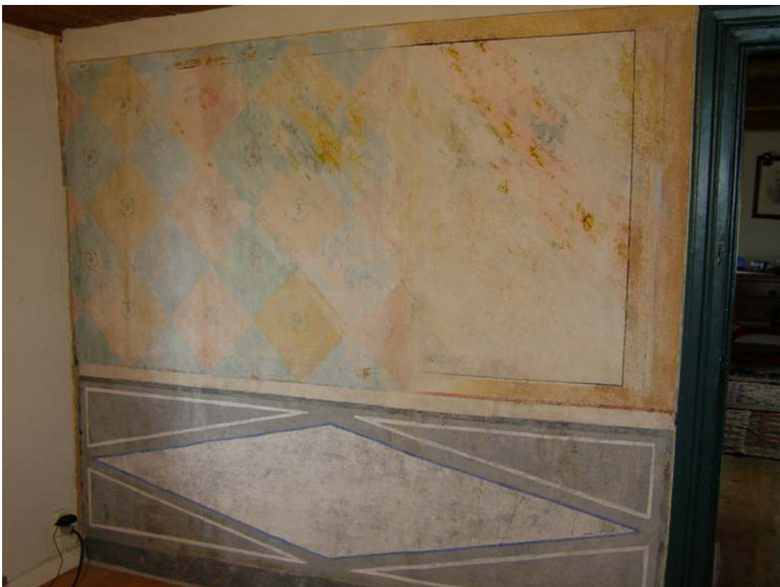
Bilderna visar det färdiga resultatet sedan lagning, infästning och retuschering har gjorts.
