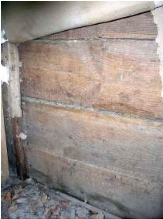
Under tapetskikten i förstugan kan man konstatera att byggnaden är uppförd i båleteknik, med stolpar och syllar av ek samt skift (bålar) av ramsågat virke.
