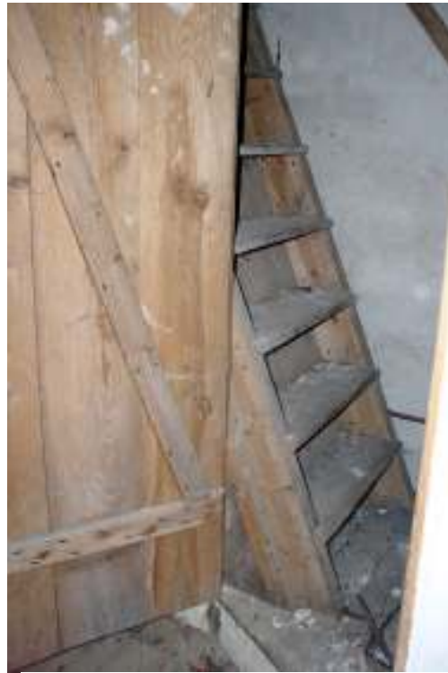
Vindstrappan återfinns bakom dörr från förstugan och löper utmed murstocken.
