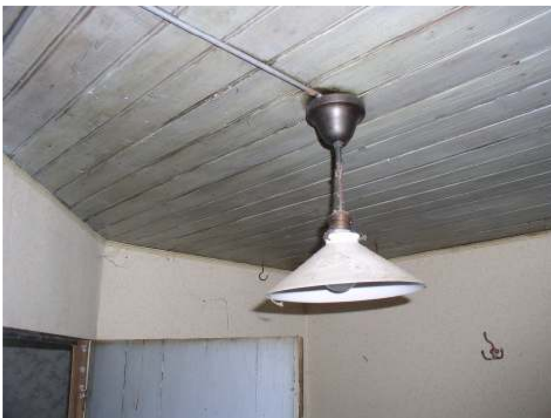
Här syns pärlspåntpanel och skomakarlampan i kökets tak.
