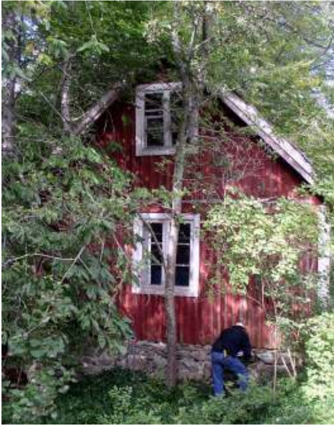
Fasad åt söder.
