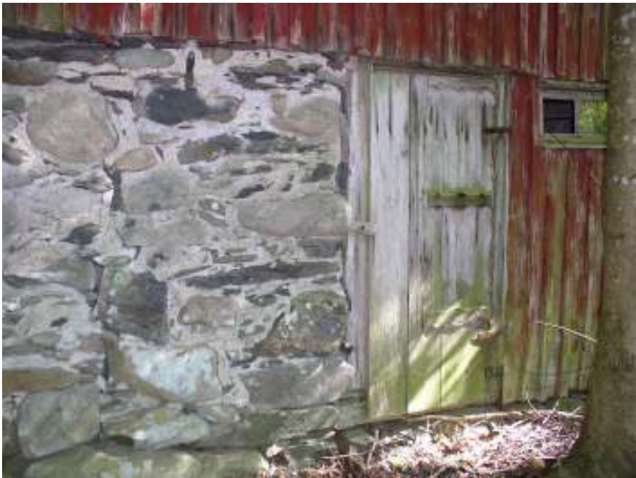
Detalj av källarmuren och källardörr.
