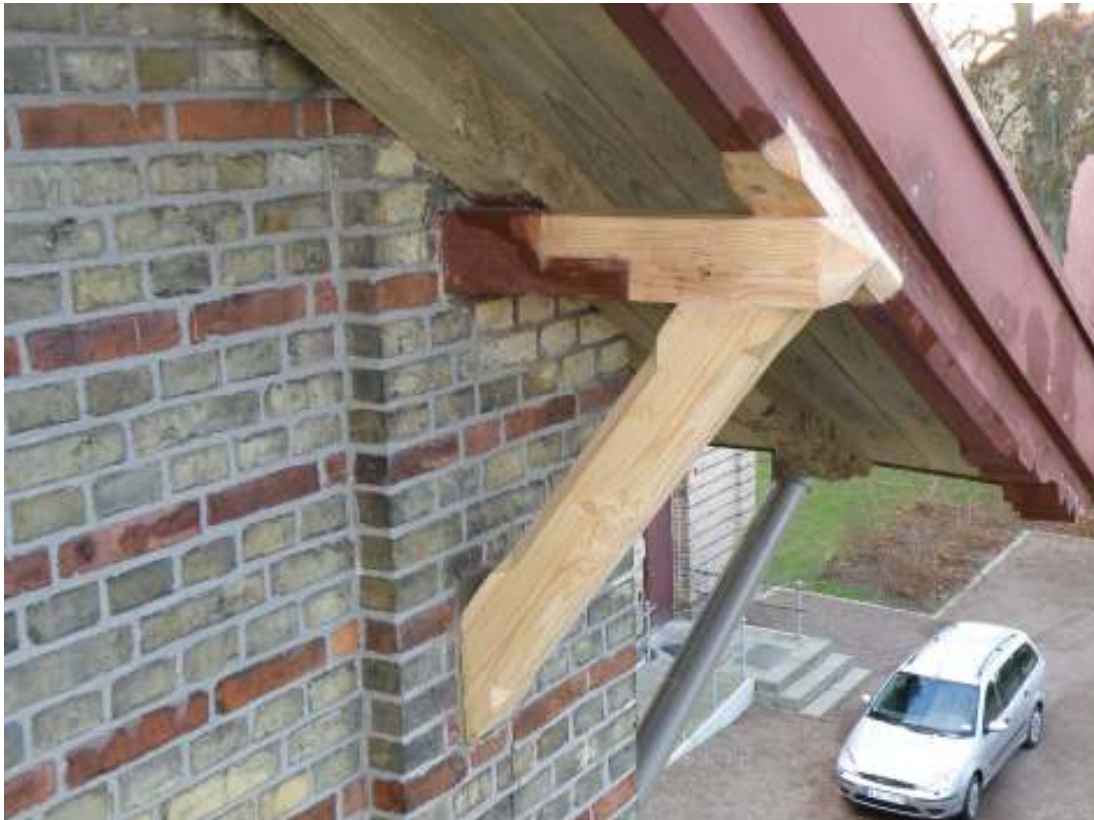
Ytterligare bilder på snickerilagningar på nordvästra gaveln.
