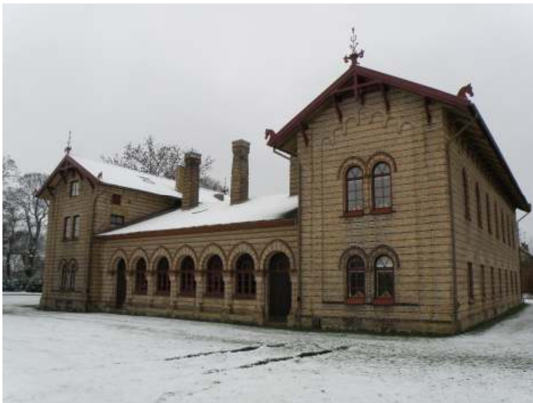
Bild 1: Hovbeslagsskolan från nordost, foto vid slutbesiktning.
