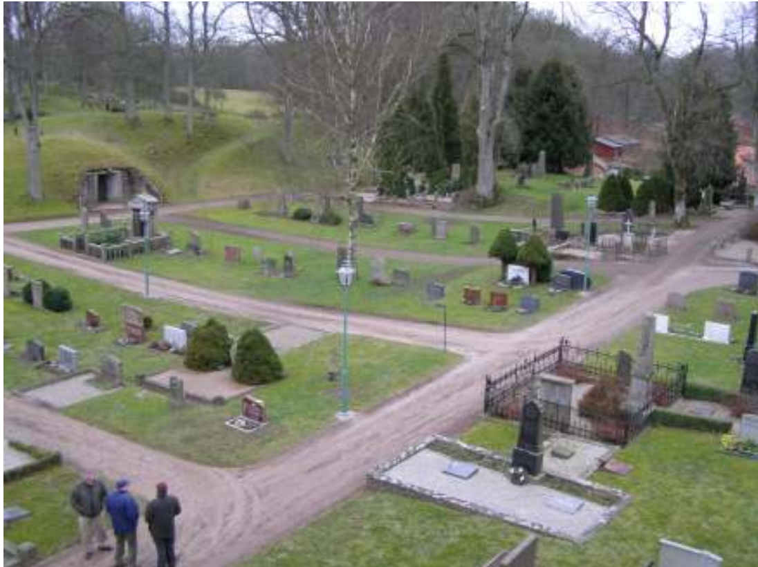
Belysningsarmaturerna på kyrkogården, söder om kyrkan. Fotot taget under slutbesiktningen.
