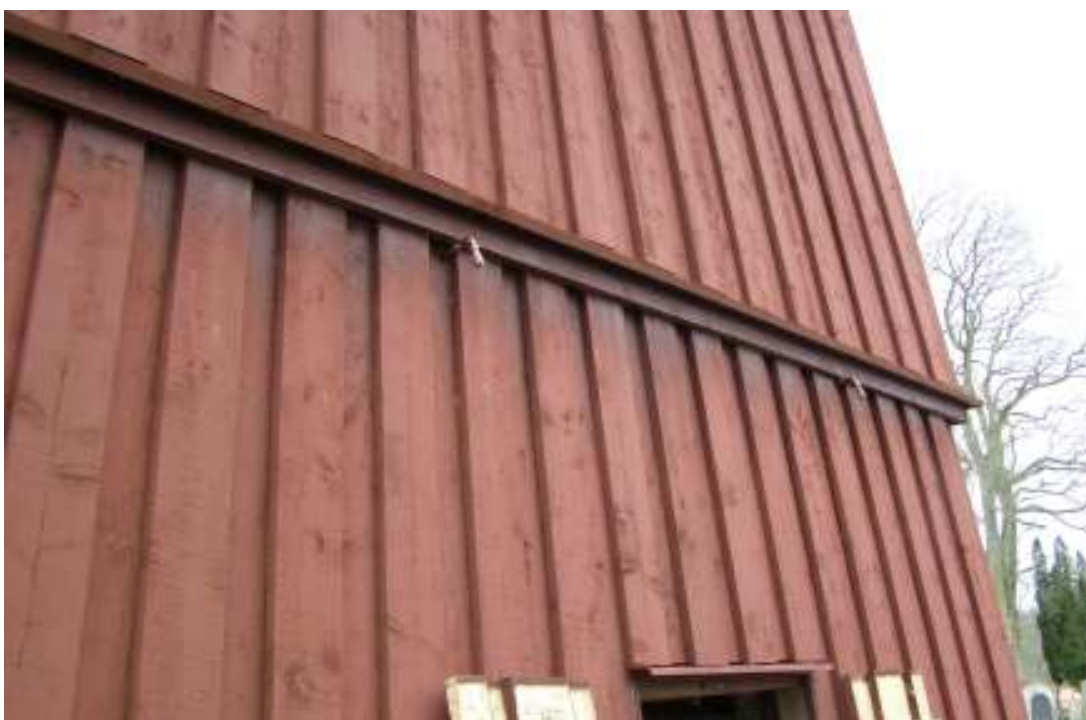
Exempel på de utvändiga spraydysorna, klockstapelns norra sida.
