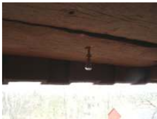
Spraydysa på takfoten.
