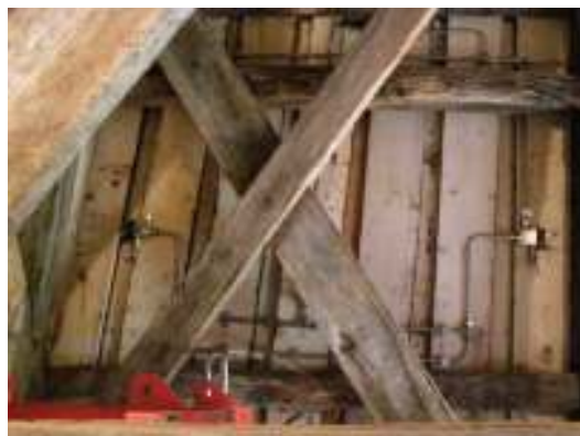
Exempel på vattenrör.
