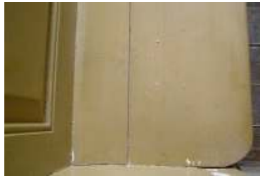
Iboplömmning av sprucken bänksits.
