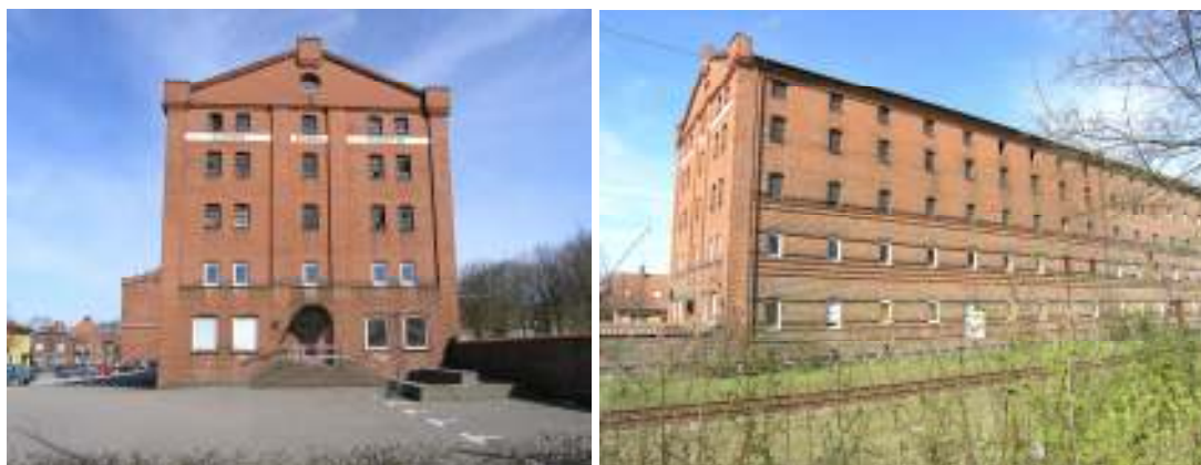
T.v. södra gaveln med namnet "Allmänna svenska utsädes AB" kvar på fasaden. Bild t.h. östra fasaden längs spåret.
