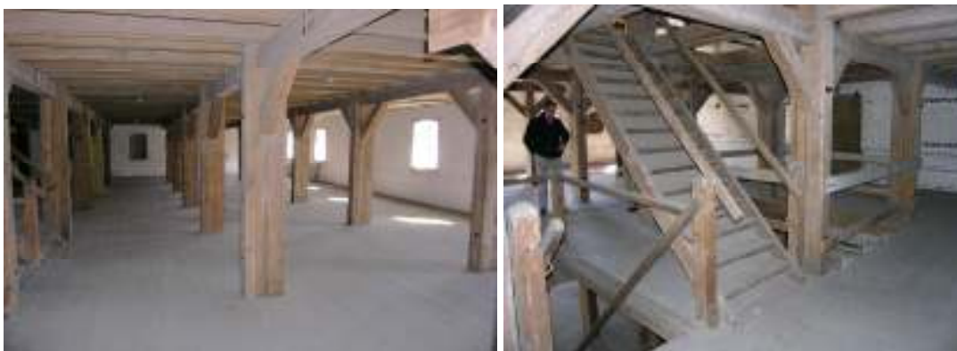
Konstruktionen i södra och norra delarna är utförd med träpelare med snedstyvor. I norra delen finns en invändig trappa.
