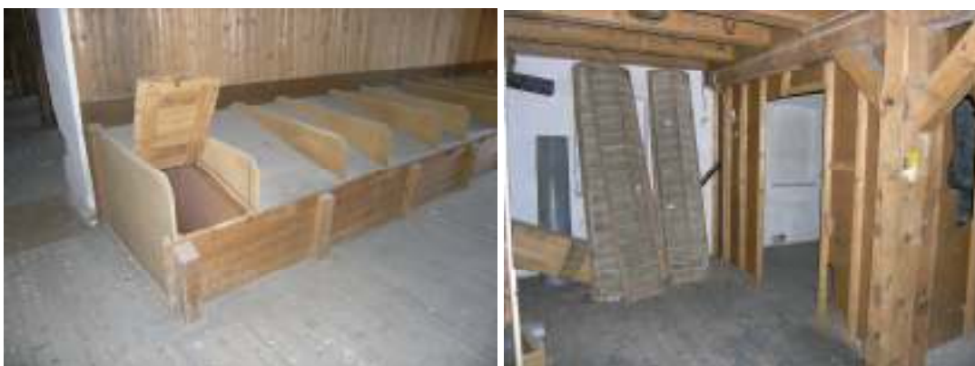
I norra delen finns några inredningsdelar kvar, bland annat fickor och delar av en typ av rensmaskin.
