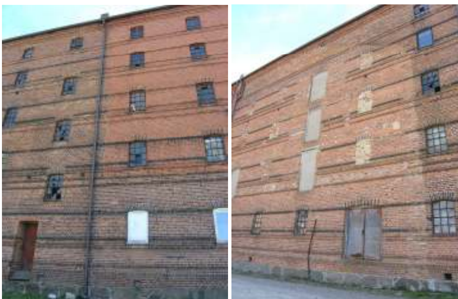
Bild t v västra fasaden med stötfog mellan del 10 b t v och 11 t b. Bilden t h: den rivna byggnaden avtecknas i västra fasaden på del 10.
