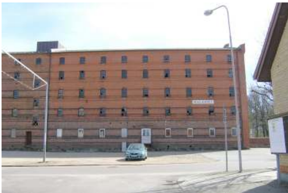
Västra fasaden av del 10 t v och del 11 t b med ljusare färg på fasadtegel.
