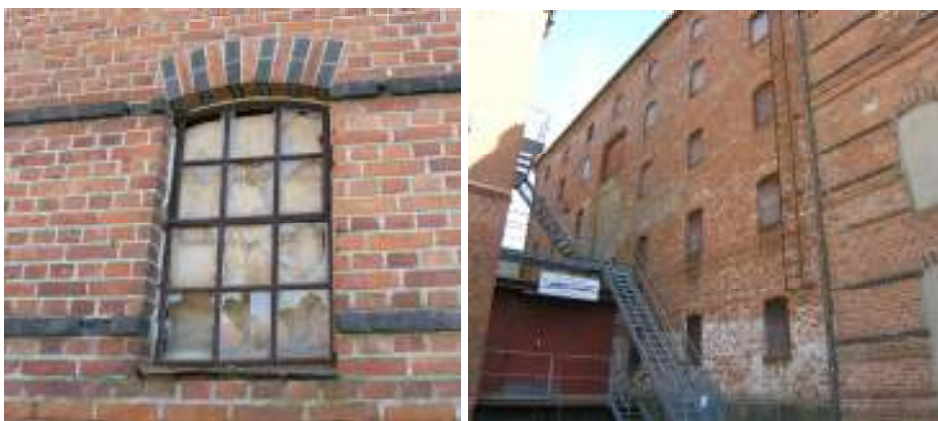
Bild t v detalj av öppningsbart gjutjärnsfönster och fasaden med kryssförband och dekorativa inslag av engoberat tegel. Bild t b del 9 med västfasad som bär spår efter att ha kalkats.
