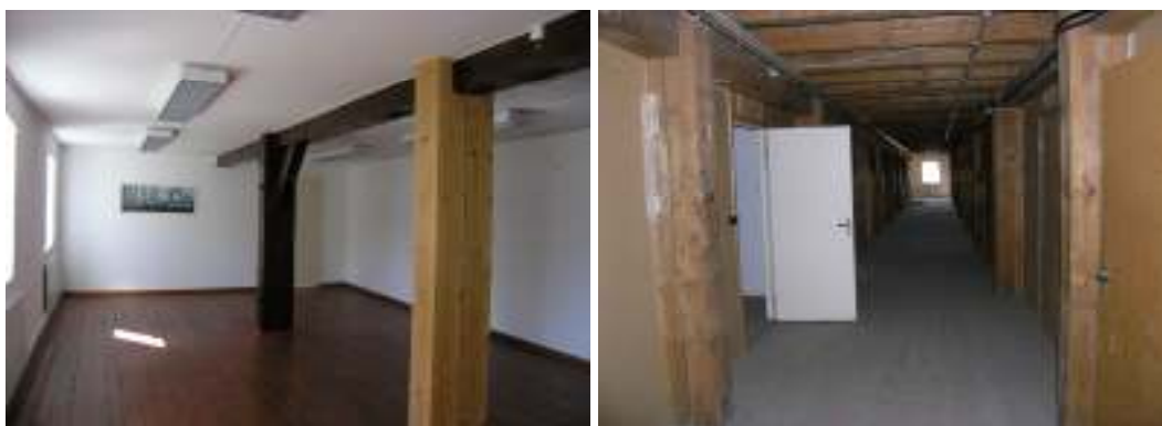
I södra delen finns delar av Modefas kontorsinredning kvar. T b ett utrymme där man påbörjat en inredning som aldrig avslutats.
