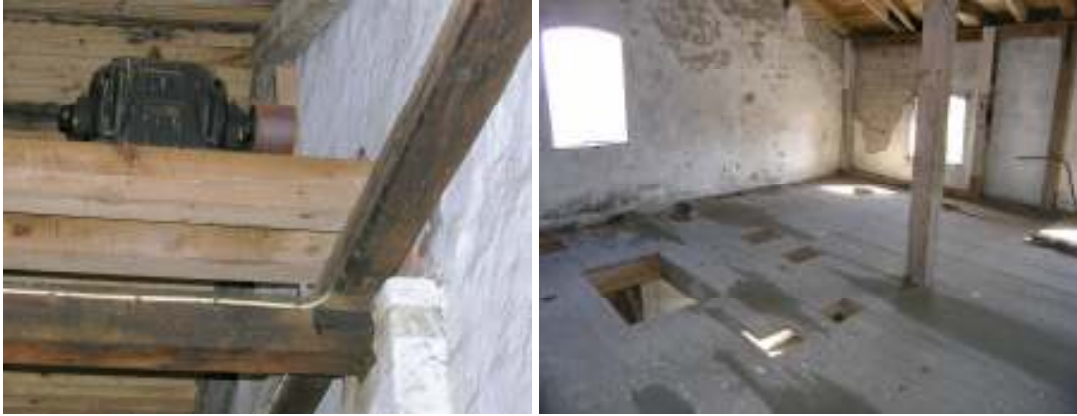
I v en elmotor finns kvar under taknocken, förmodligen har den använts för att lyfta säckar. T b hål i brädgolvet i del 9 visar var enklare maskineri varit placerat.
