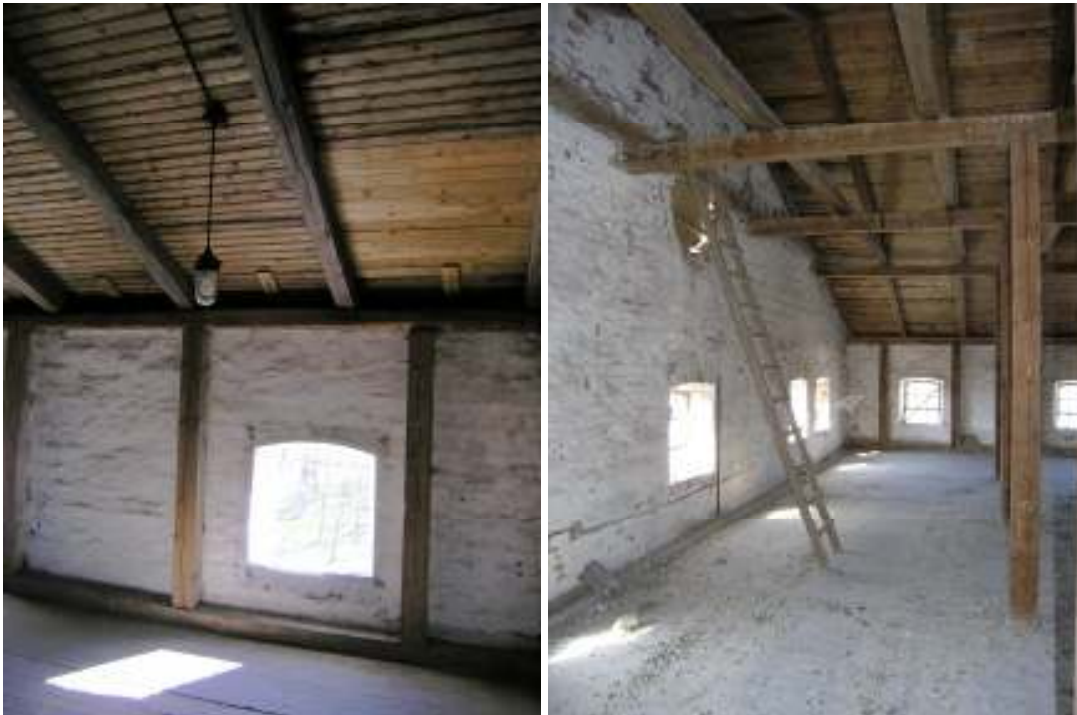
Konstruktionen är enkel och tydlig, äldre armering finns kvar.
