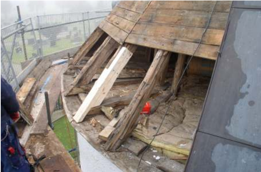
Absiden under arbete. Bladskarvad sparre vid norra delen.
