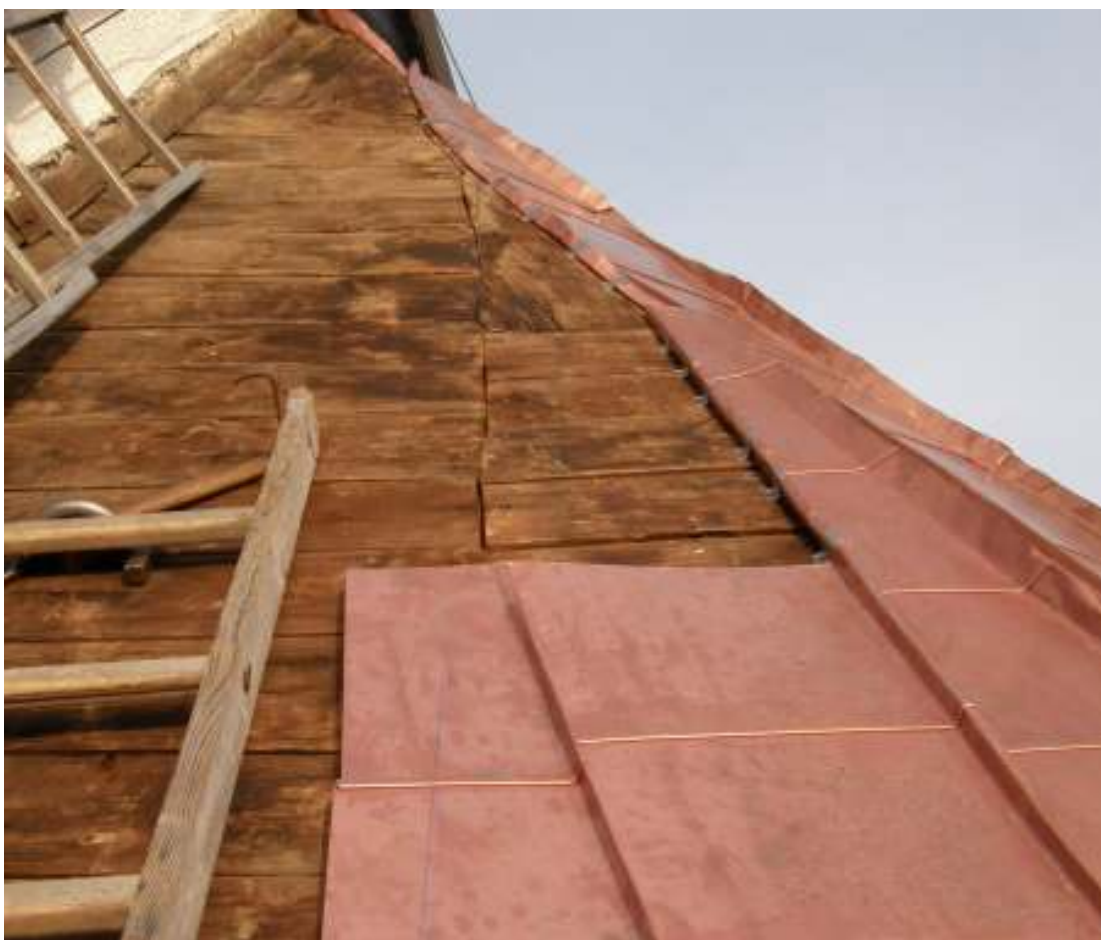
Plåttäckning direkt på absidens underbrädning.
