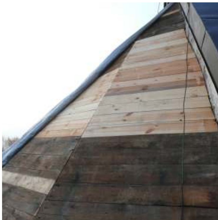
Partiellt bytt underbrädning på absiden. Foto Sven-Åke Nilsson.
