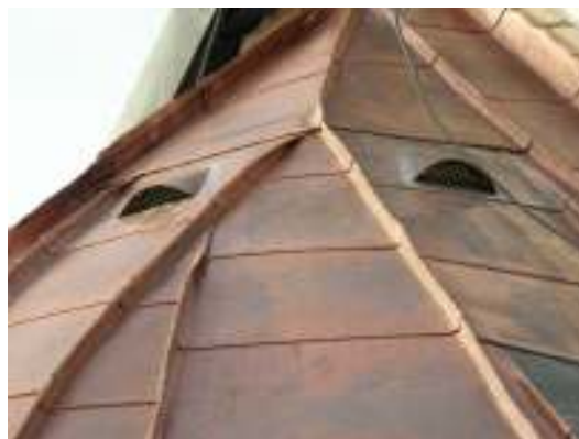
Pålöddade ventilbuvar, östra och norra sidan.
