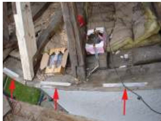
Ventilhålen täckta med rostfri hållplåt.
