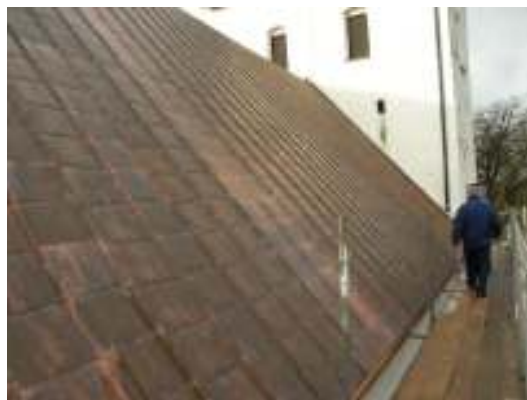
Ny koppartäckning, norra takfallet.
