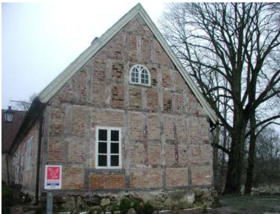
Bild 22: Byggnad D östra gaveln, foto 2007
