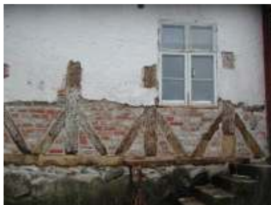
Bild 4-7: Byggnad C västra fasaden under och efter arbete med timmerlagningar
