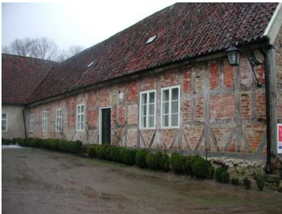
Bild 21: Byggnad D södra fasaden efter renovering, foto 2007.
