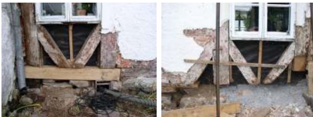
Bild 8-9: Byggnad C östra fasaden under arbete med timmerlagningar
