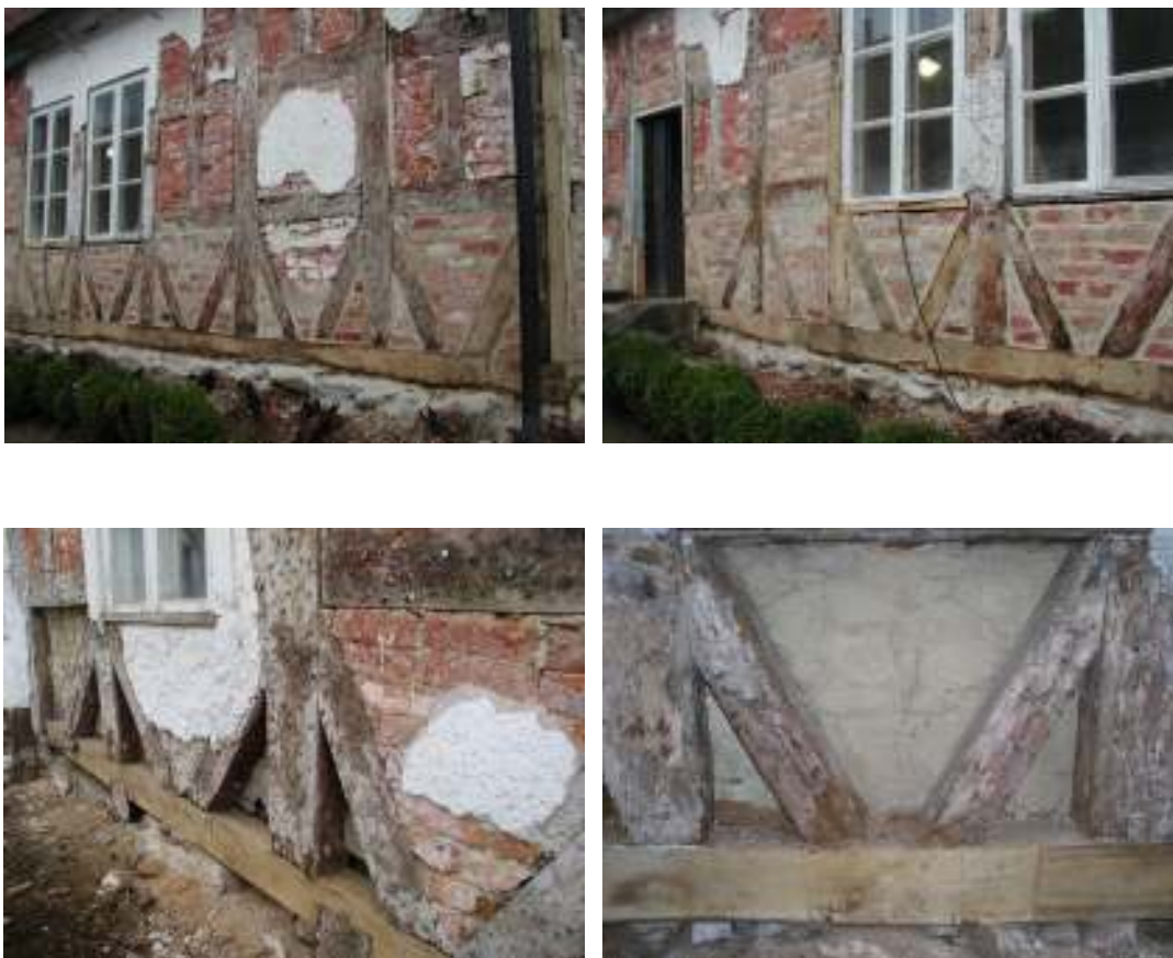
Bild 17-20: Byggnad D södra fasaden efter arbete med timmerlagningar
