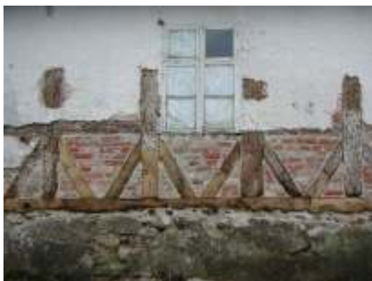
Bild 4-7: Byggnad C västra fasaden under och efter arbete med timmerlagningar
