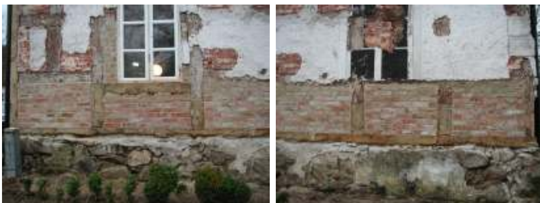
Bild 15-16: Byggnad D östra fasaden efter arbete med timmerlagningar
