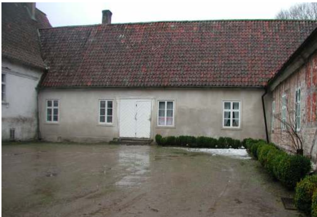
Bild 10: Byggnad C, östfasaden efter renovering, foto 2007
