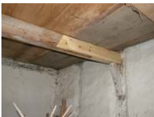
Skarvad bindbjälke i Kistehuset.
