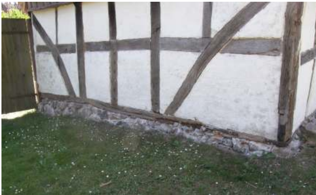
Exempel på från cementhaltigt bruk rengjorda syllstenar.
