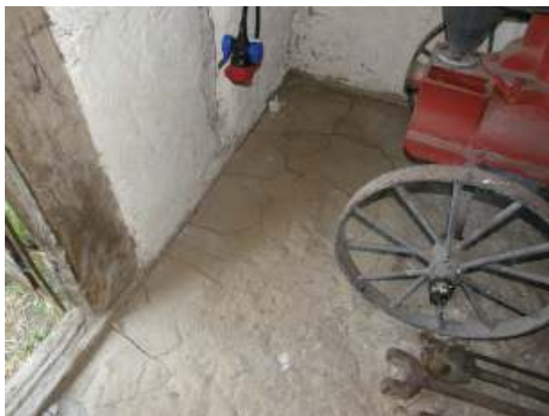
Det kompletterade lergolvet i västra längan.
