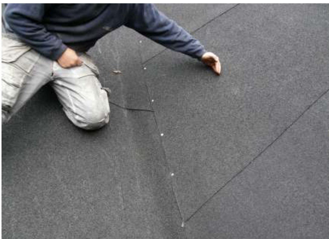
Detalj, V ränn dalen efter omtäckning. Överlappning gjord upp till handen.
