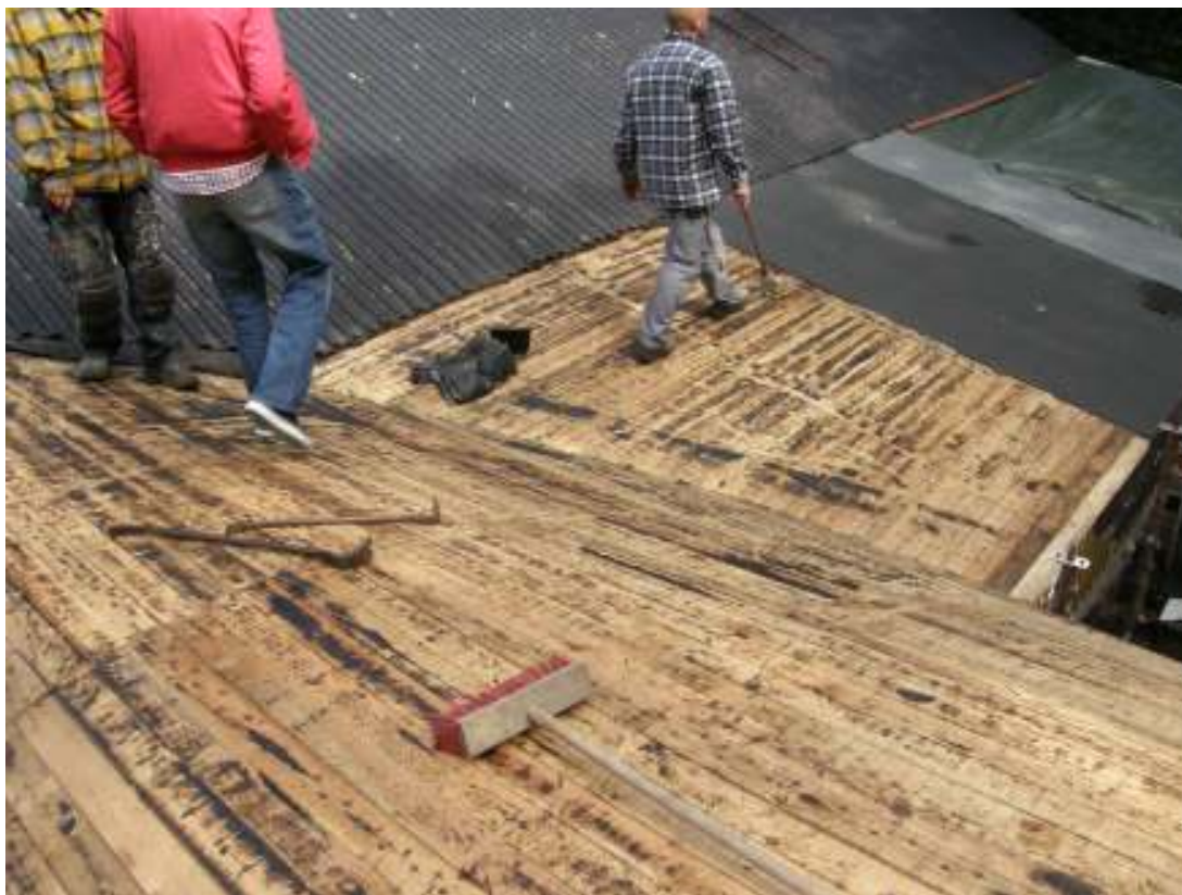
Underbrädningen efter att takpappen avlägsnats.
