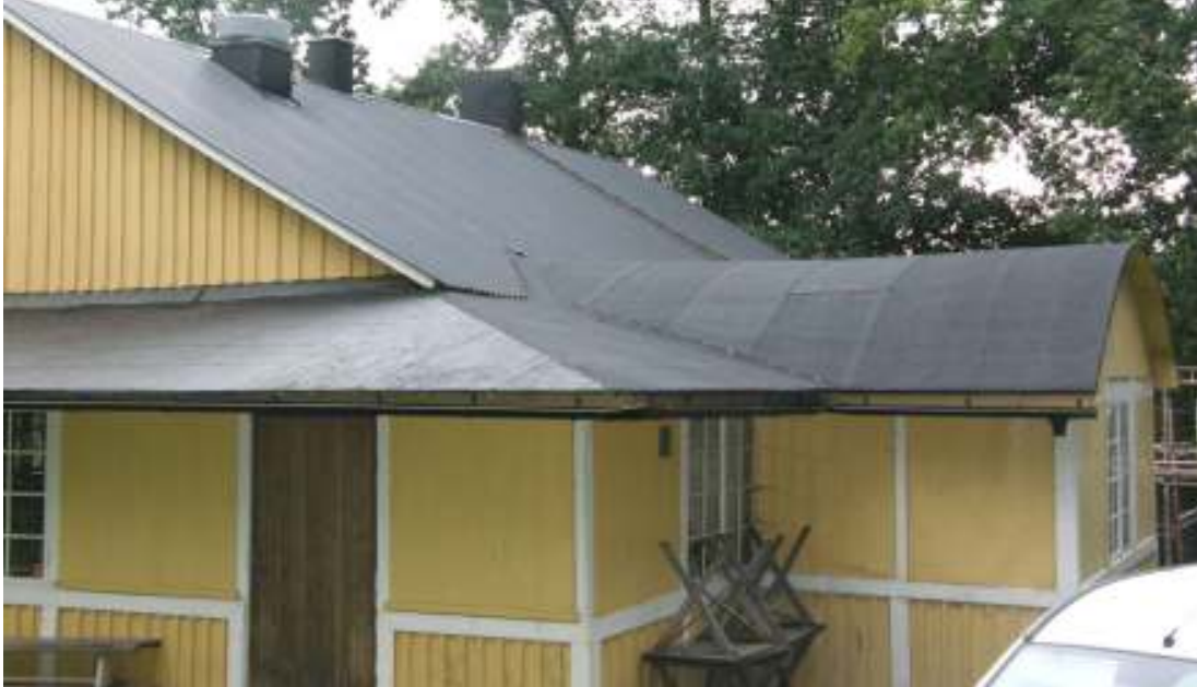
Efter omtäckningen, vy mot NÖ.
