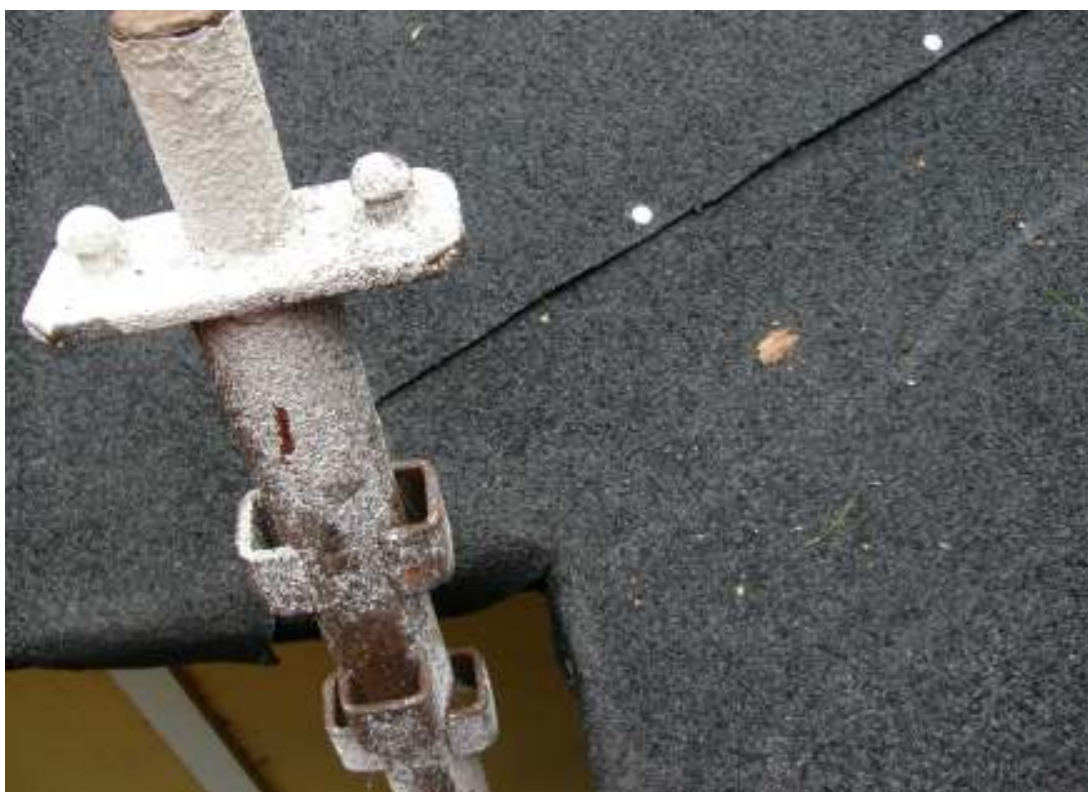
Detalj, Ö ränndalens takfot.
