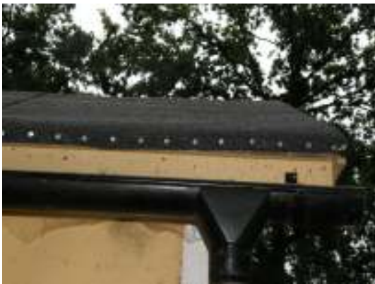
Detalj, spikning av papp vid takfoten.
