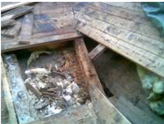
✓ rännviden, rötskada borttagen.
