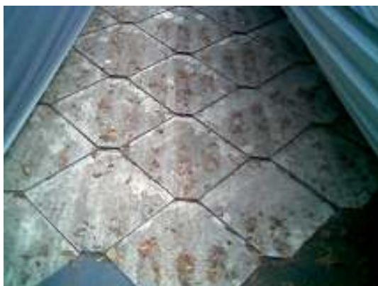
Eterniten under plåtskivorna.
