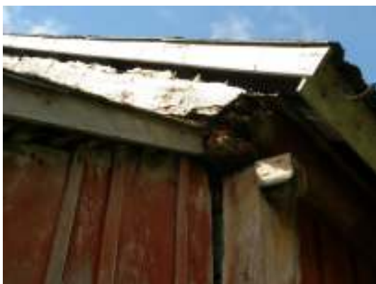
Norra utanpå sittande sparren, innan arbetet.
