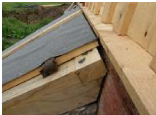
Detalj, ny konstruktion.
