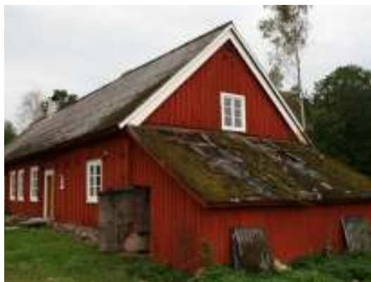
Östra gaveln efter arbetet.
