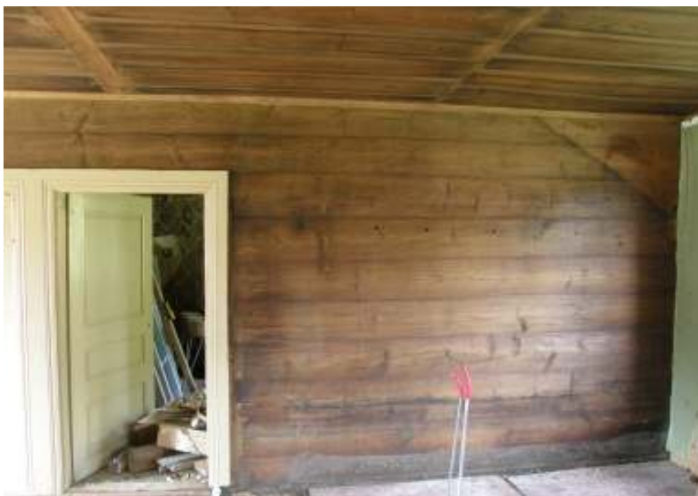
Stuans västra vägg. Notera de återanvända takpanelbrädorna och markeringen till höger på väggen, där den tidigare ryggåstakvinkeln visar sig.
