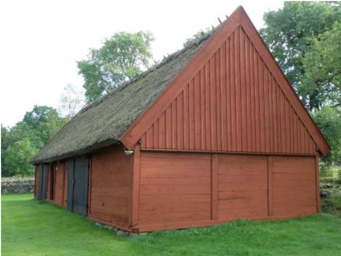
Bild 9: Logens framsida före omläggning av tak.
