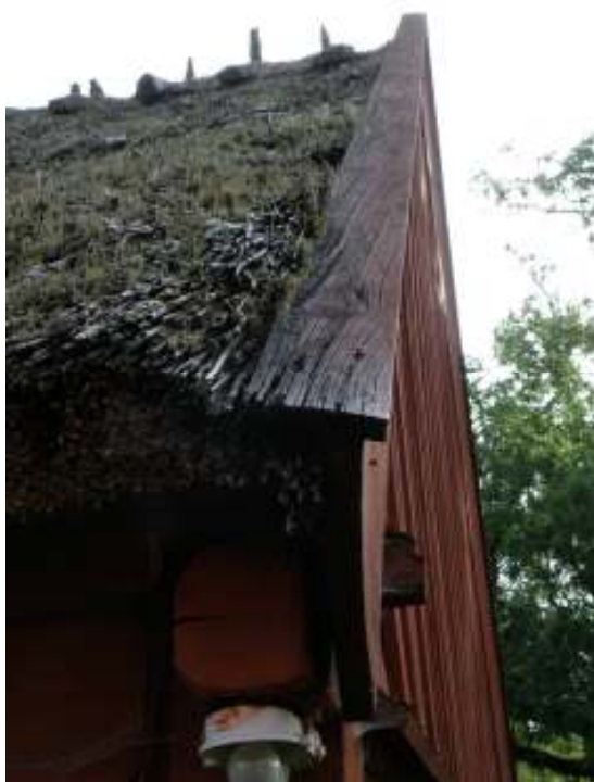
Bild 7: Röttskadad vattbräda
