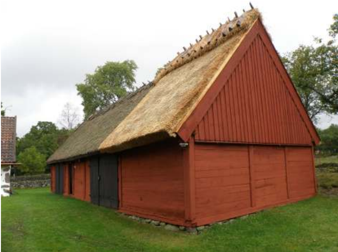
Bild 10: Logens framsida efter omläggning av tak.
