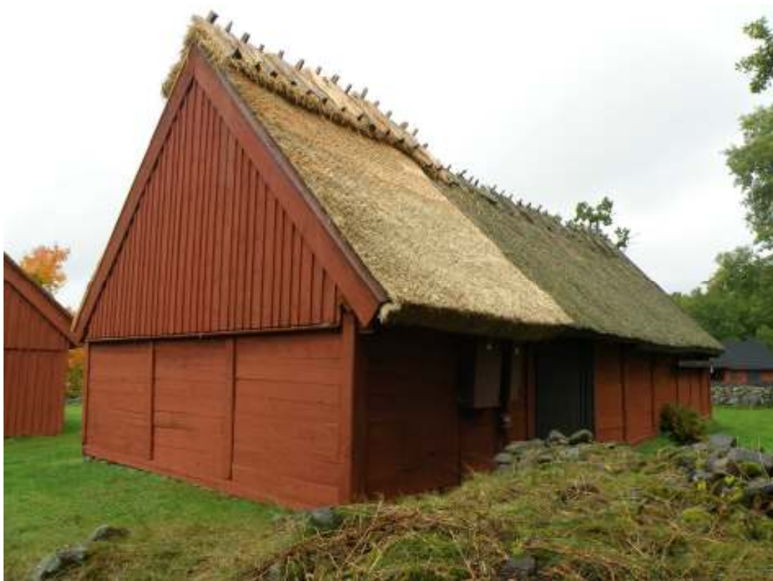
Bild 12: Logens baksida efter omläggning av tak.
