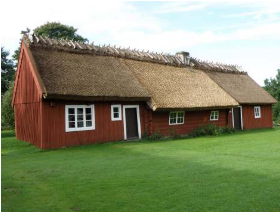
Bild 4: Mangårdsbyggnaden vars tak har lagts om från vass till halm i omgångar mellan åren 2005-2007.
