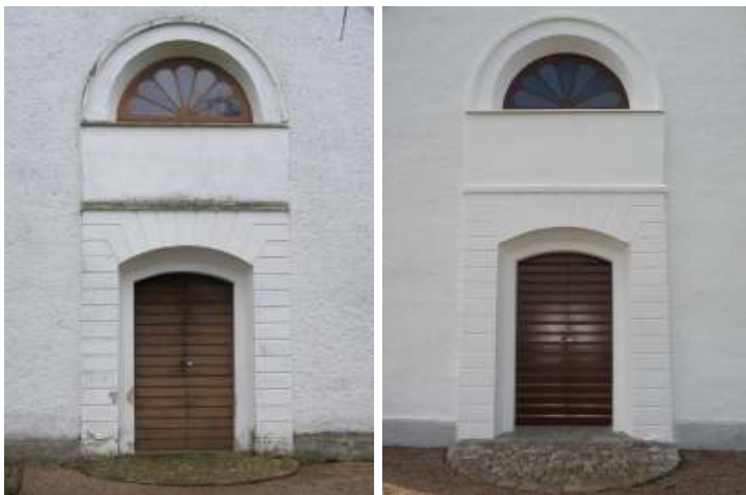
Bild 16 och 17: Den norra korsarmens dörr före och efter ommålning.
