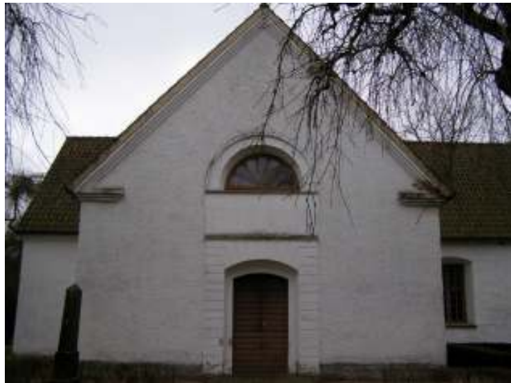
Bild 9: Norra korsarmens norra fasad före omputsning.
