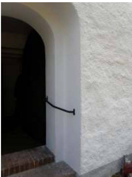
Bild 19: Västpporten återställd efter rostskydd av hängslen.
