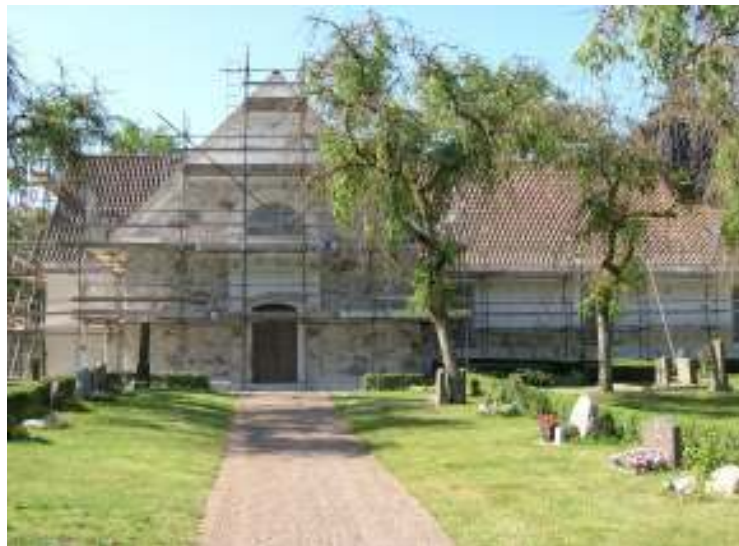
Bild 10: Norra fasaden efter putsnedtagning.
