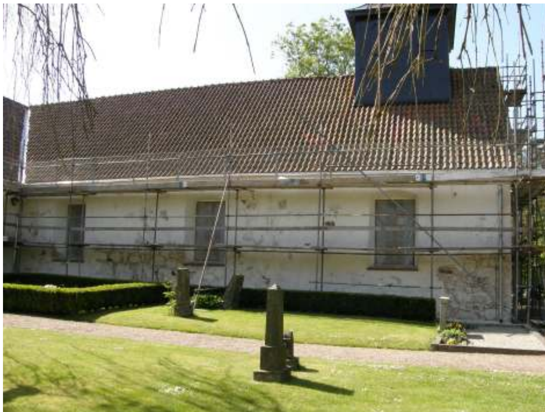
Bild 22: Omfattning av putsnedtagning inför murverksdokumentation. Efter nödvändig dokumentation kunde arbetet tas upp igen med en mer begränsad nedtagning.
