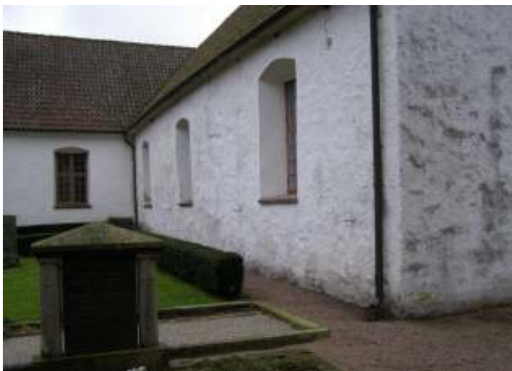
Bild 6: Norra långhuset före årets arbeten.
