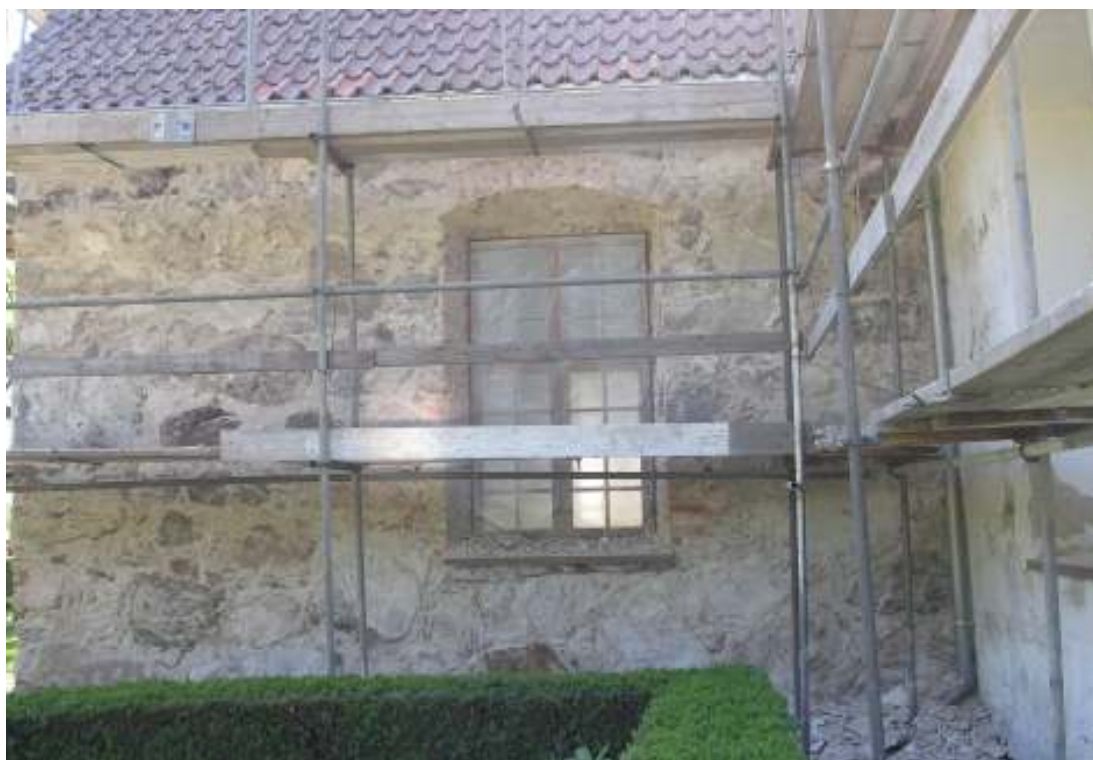
Bild 26: Västra fasaden på norra korsarmen med blottlagt murverk.
