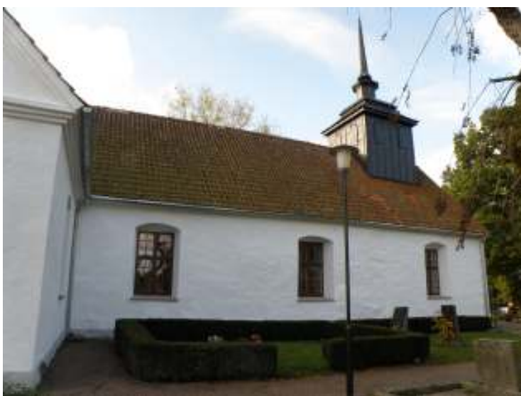
Bild 8: Norra långhuset efter årets arbeten.
