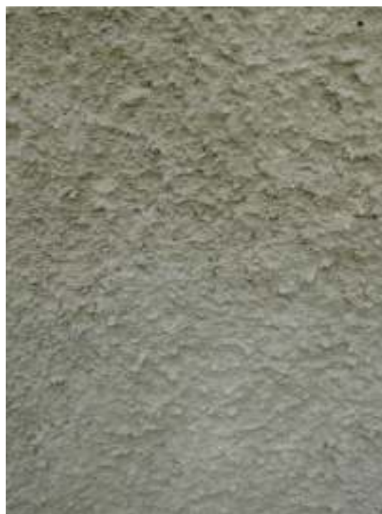
Bild 20: Strukturen på putslagning, långhusets norra fasad.
