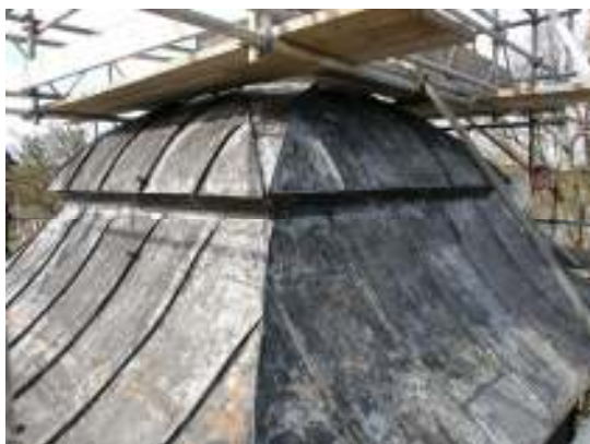
Bild 12: Tornets huv efter skrapning
