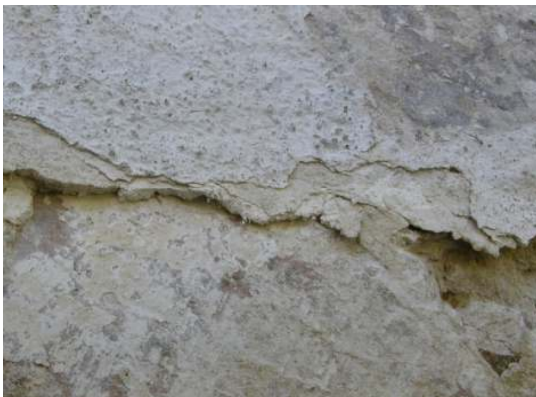
Bild 25: Åtskilliga putslager återfanns på långhusets norra fasad, nertill i bild syns en kalkad sten och överst en nyare spritputs.
