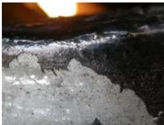
Bild 13: Tjärat lager på tornets plåt.
