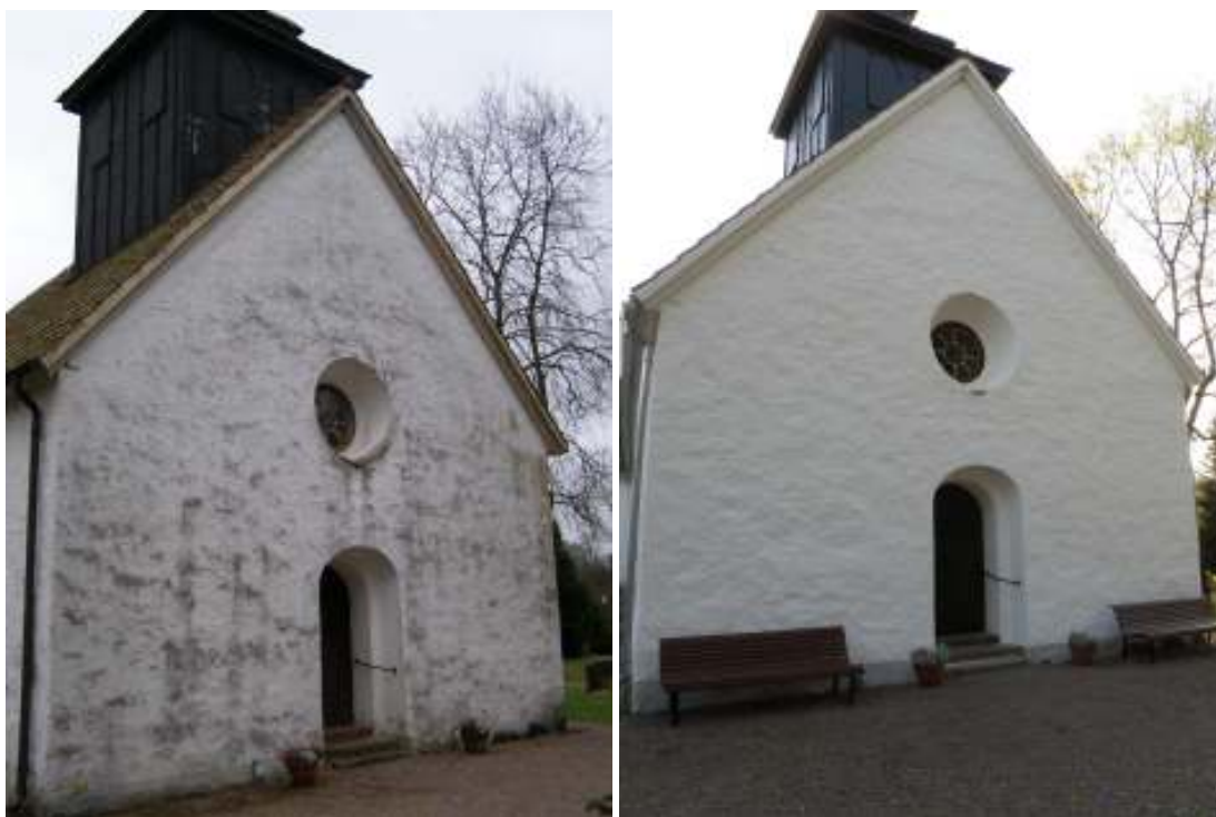
Bild 4 och 5: Västra gaveln före och efter arbetena.
