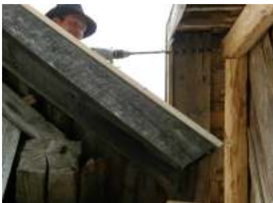
Arbetsbilder från infästning av norra längans östra, utanpå sittande taksparrar.
