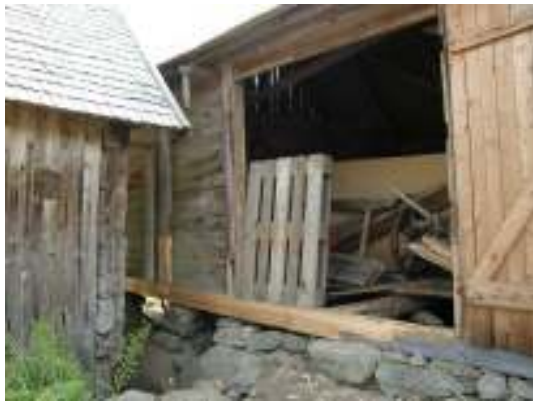
Västra syllen bytt och stolpar skarvade.
