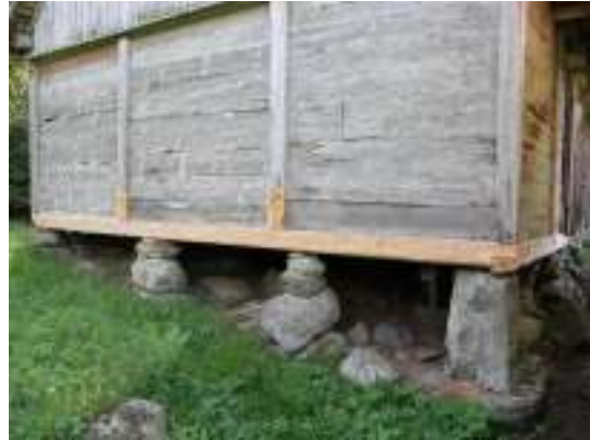
Norra syllen bytt och stolpar skarvade.
