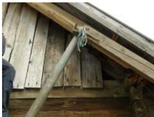
Arbetsbilder från infästning av norra längans östra, utanpå sittande taksparrar.
