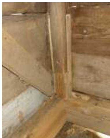
Nordvästra stolpskarven på östra ekonomilängan. Principritning och på bild.
