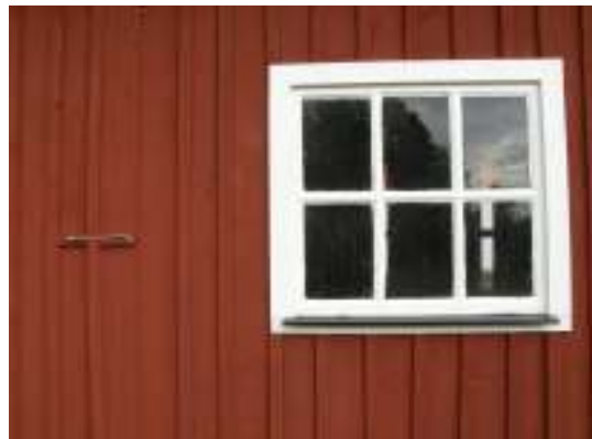
Lucka och fönster å västra långsidan.
