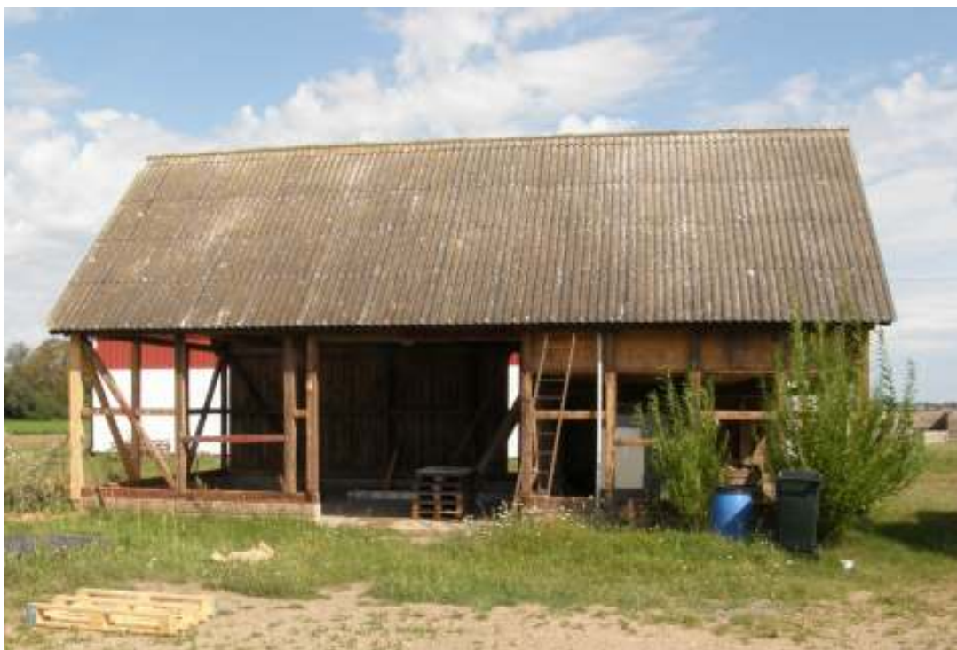
All rötskadad panel nedtagen.
