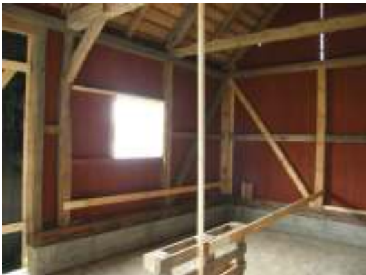
Invändigt efter att ny panel monterats.
