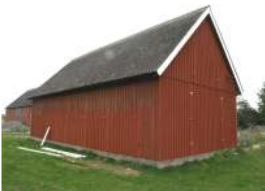
Norra långsidan under ommålningsarbetet.
