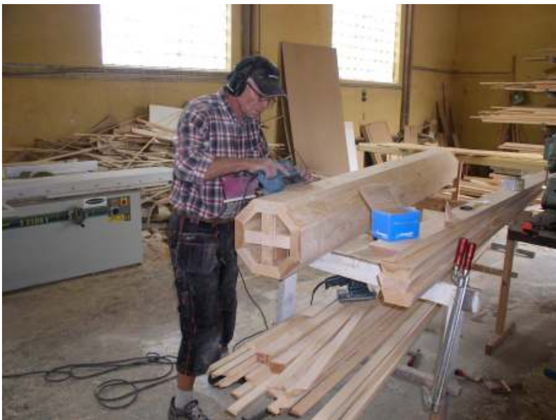
Balkongpelarna under tillverkning.
