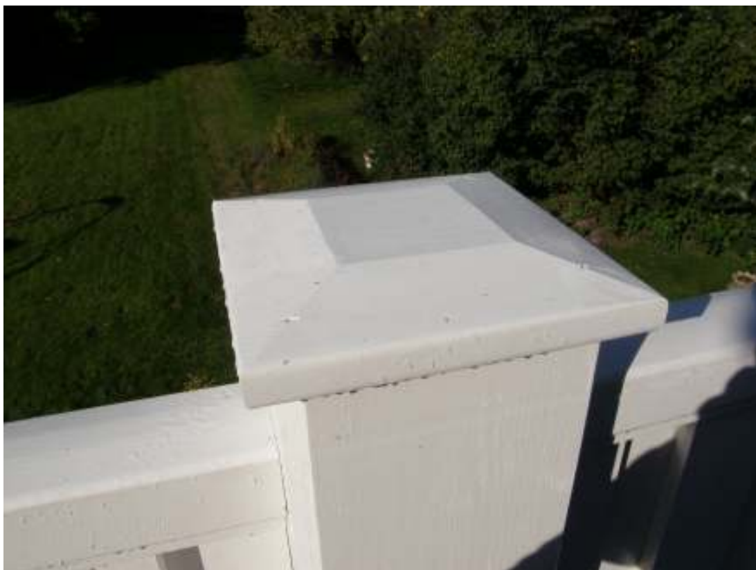
Detalj av stolpkrön å ny räcketolpe.
