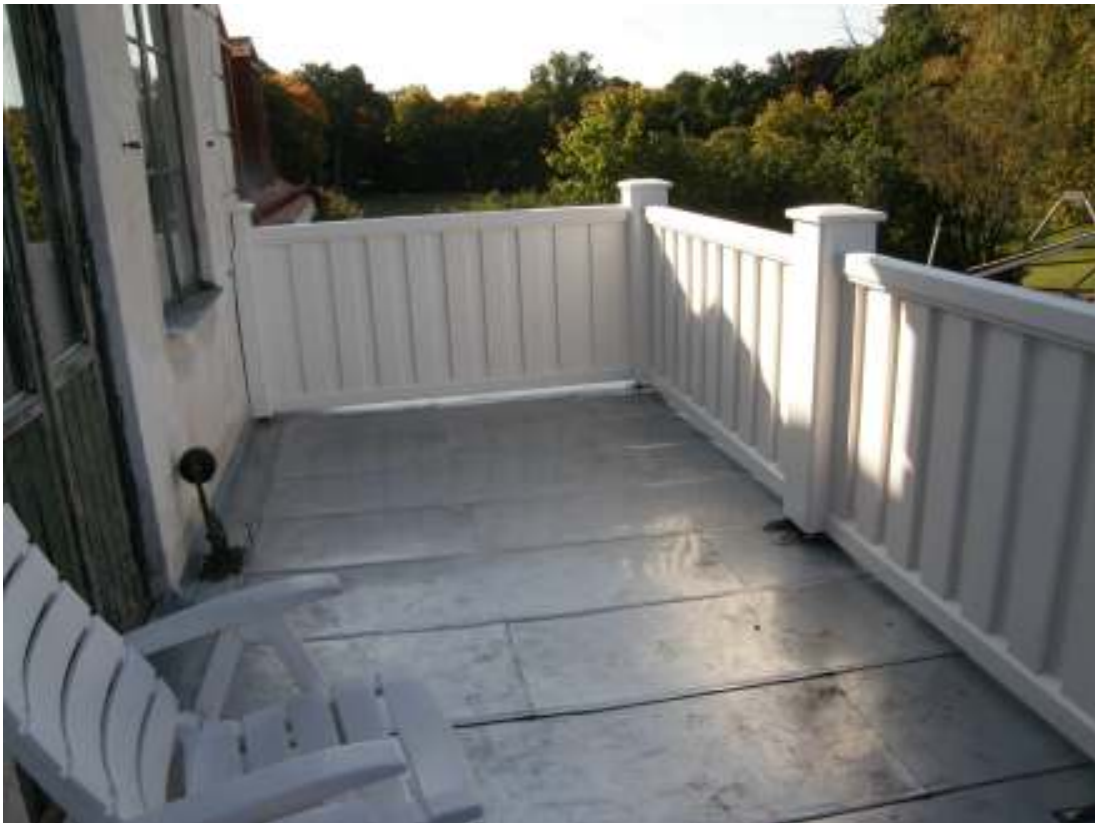
Ny plåttäckning och nytt räcke.
