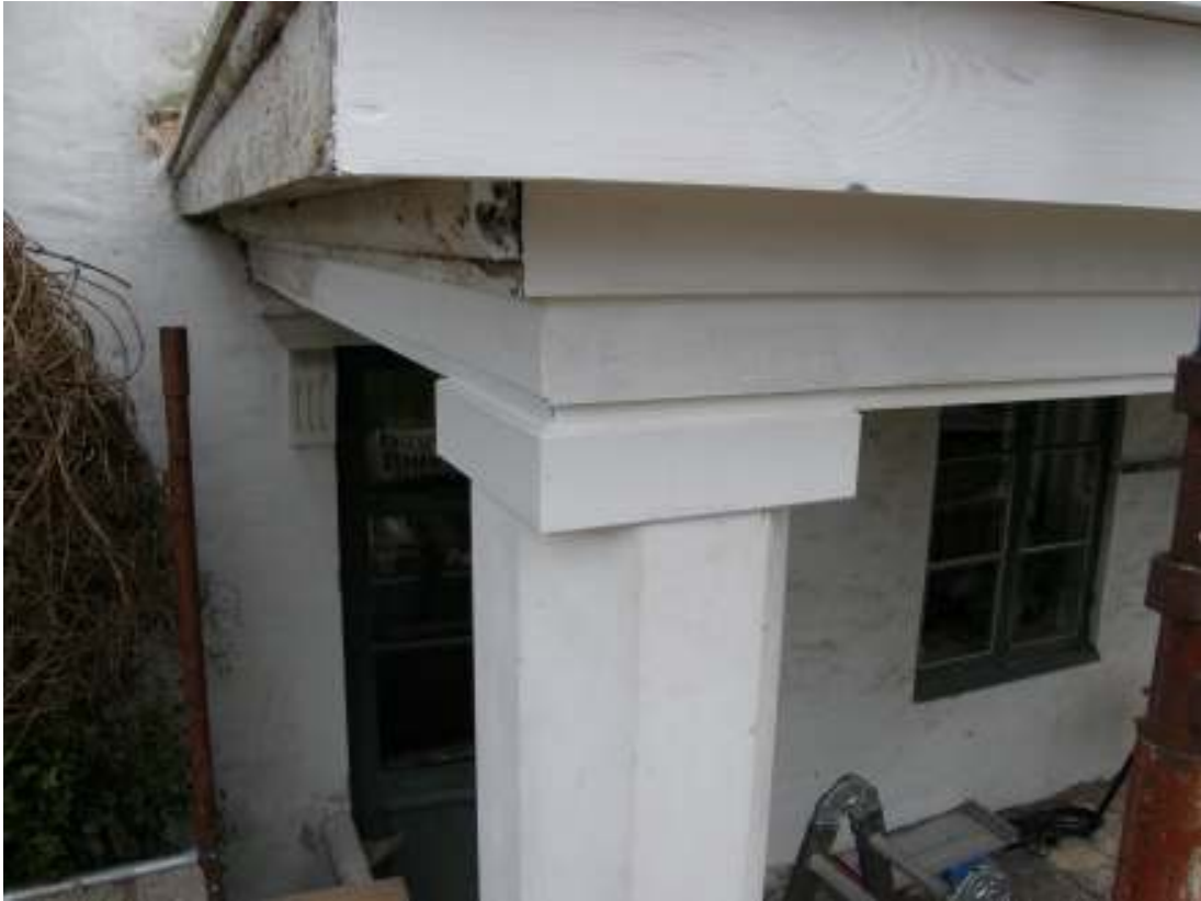
Detalj av den nya norra pelaren, inkl kapital och lejd. Ny kvartsstav ännu ej monterad.
