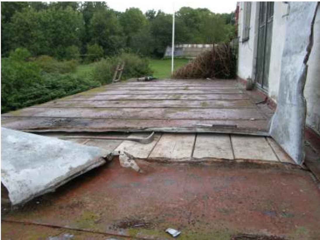
Det gamla plåttaket under borttagande.
