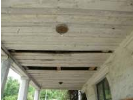
Balkongens undertak före påbörjat arbete.
