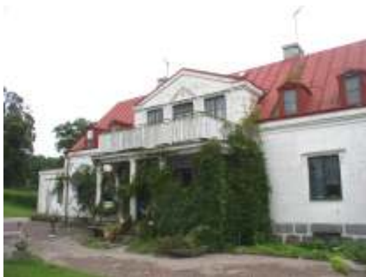
Balkongen före arbetet...
