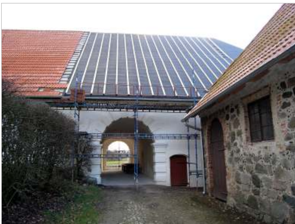
Underlagspapp och trekantsläkt på plats över södra delen, det gamla porttornet.
