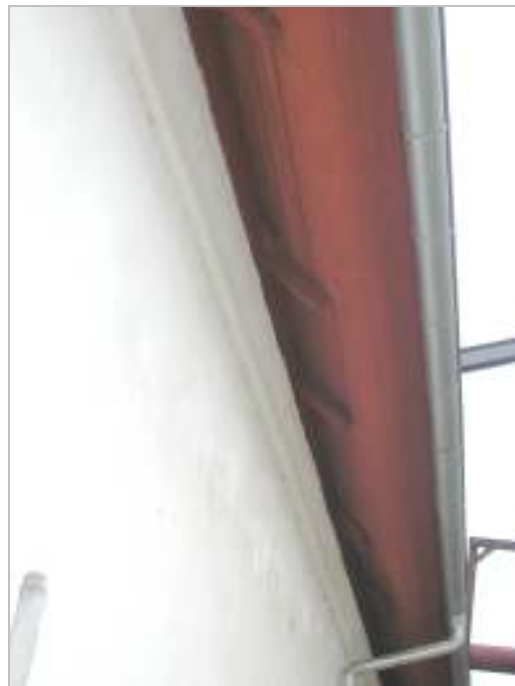
Ovan: Detaljbilder av påbyggd takfot och underlag samt den nya avvattningen, som kommer att lämnas omälad.
