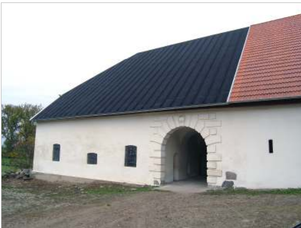
Fasad åt öster efter slutförda arbeten.
