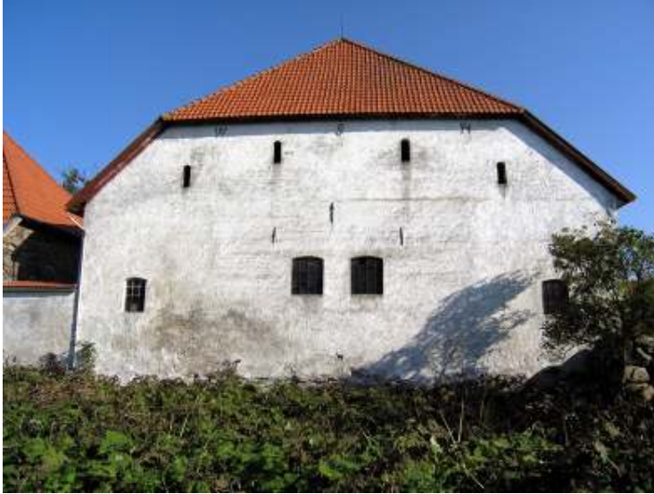
T v. Byggnadens södra gavel är en rest av porttornet från 1500-talet.
