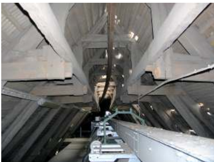
Takstol över mellersta delen av "Gamla hissgogan". Här syns hur takstolen blivit kraftigt ombyggd och avväxlad i samband med att lastskenan monterats på 1930-talet. Denna del har ett äldre sticketak synligt inifrån.
