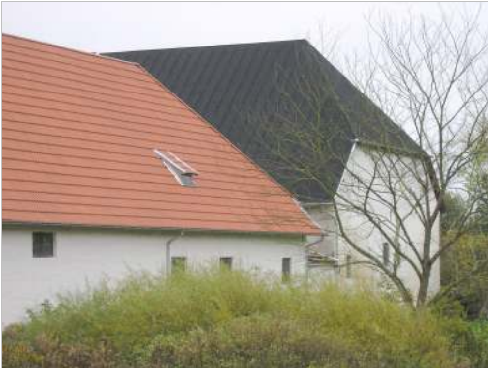
Södra ladugårdslängan och södra delen av den "Gamla hisslogan". Avvattningen är idag väl påtaglig, men intrycket kommer att mattas med tiden. Plåtdetaljer i anslutning till tak ska däremot målas röda.
