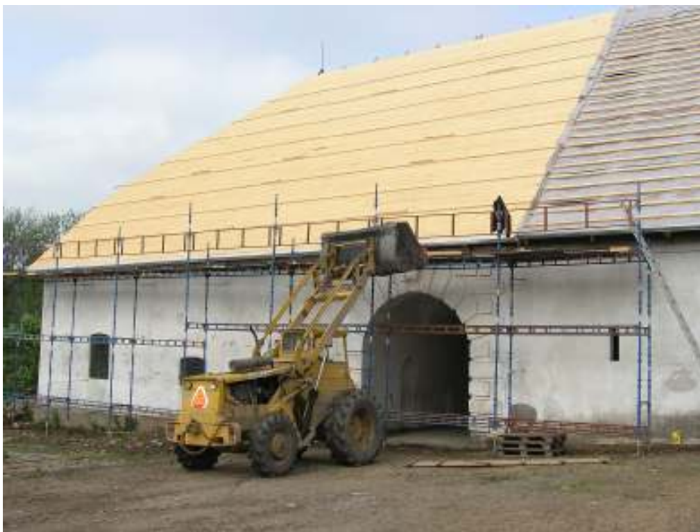
Ny råspont har spikats på den nya "lätta" takstolen i södra delen. Till höger syns Supergriden, väven som lagts under läkt och Nibra-pannor.
