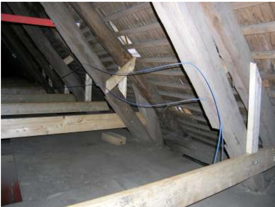
Detalj av förstärkning av takstol.
