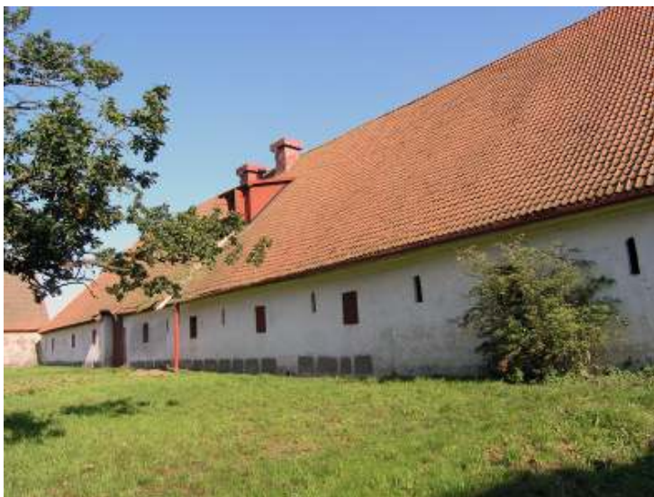
Fasad åt väster före takomläggning.
