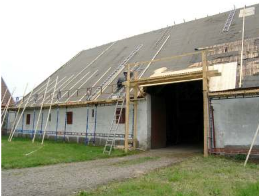
Takfall åt väster, norra delen. Den här belägna porten höjdes något.
