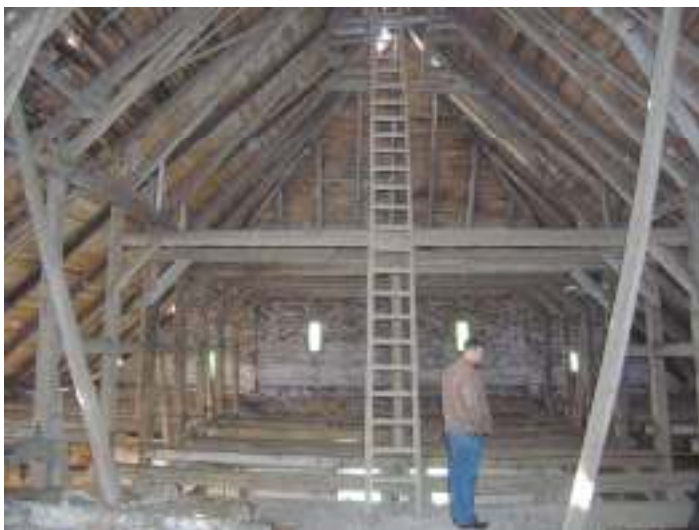
Takstol över den gamla porttornsdelen i söder.
