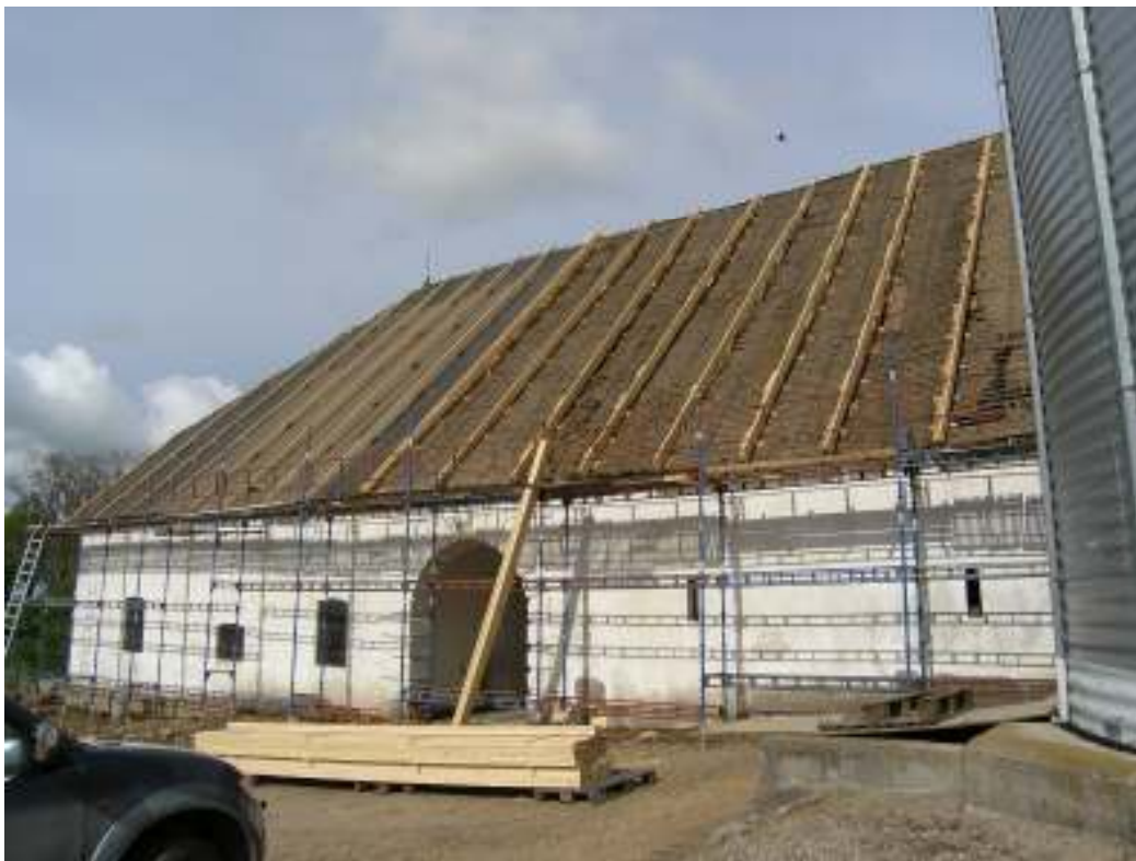
Ny "lätt" takstol har monterats ovanpå befintligt undertak, som därmed bevarats.
