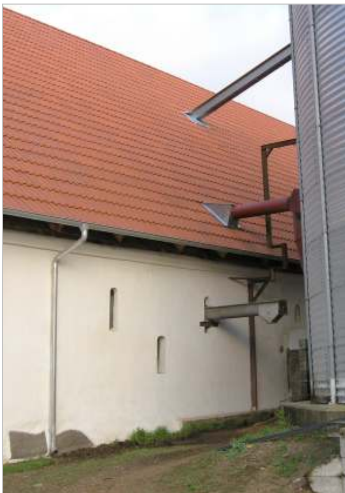
Ovan: Detaljbilder av påbyggd takfot och underlag samt den nya avvattningen, som kommer att lämnas omälad.
