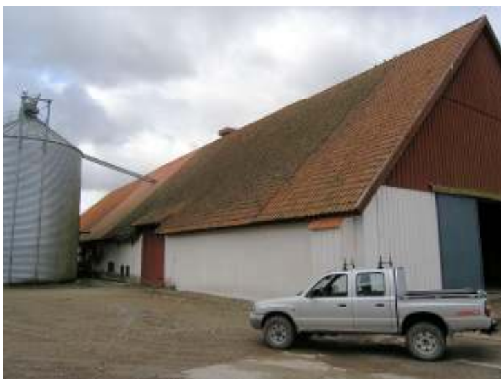
Fasad åt öster, norra delen, före takomläggning.
