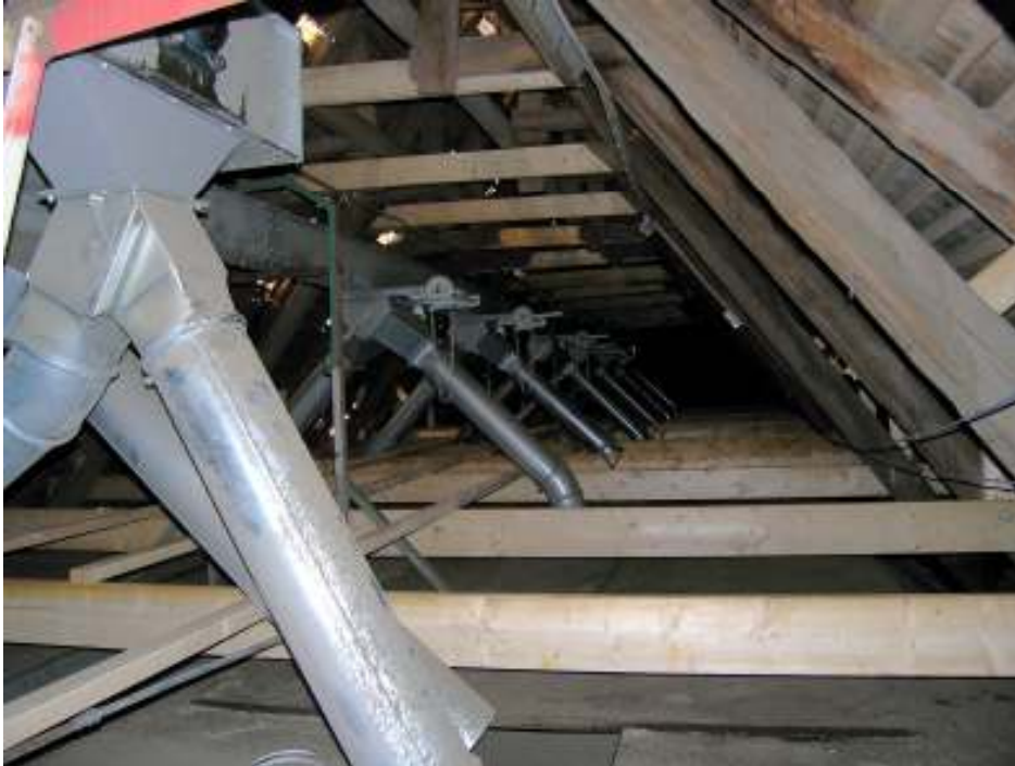
Förstärkning av takstol i byggnadens mittparti visade sig vara nödvändig att utföra.
