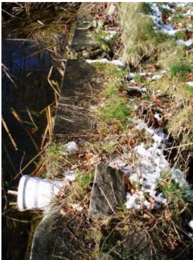
Bild 4: In- och utfödet i de båda dammarna sker vid PVC-rör. På bilden syns även den betongsarg som finns i damm 2:s norra kortände.
