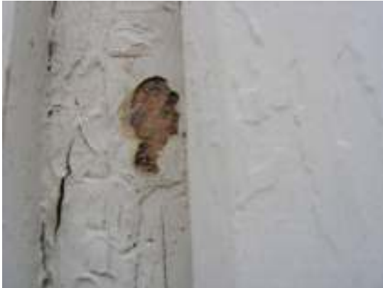
Färgundersökning av skikt med tjärblandad linolja på skolbyggnadens norra gavel.
