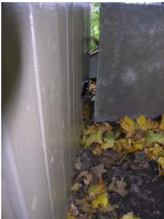
Trång passage mellan uthusets norra gavel och det gjutna betongkaret.
