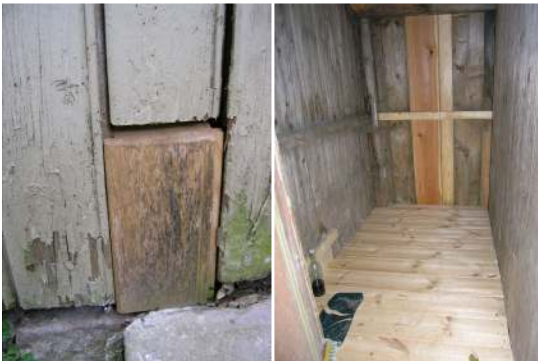
Lös panel på uthuset har fästs in och i det vänstra dasset har ett nytt golv lagts in.
