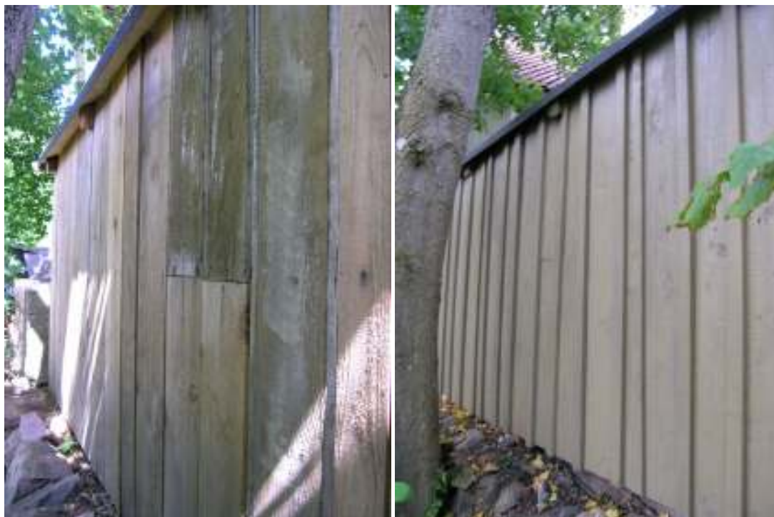
Uthusets baksida där panelen nu har kompletterats med skyddande locklist.
