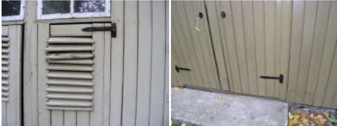
Dassdörrarnas vädringslameller har restaurerats, beslagen riktats och låsen smorts upp.
