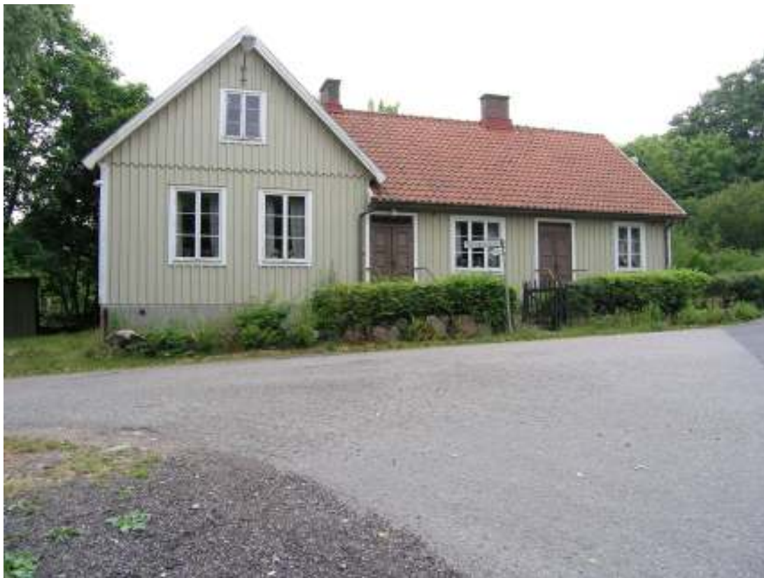
Fjälatorps småskola med uthus som skymtar till vänster.
