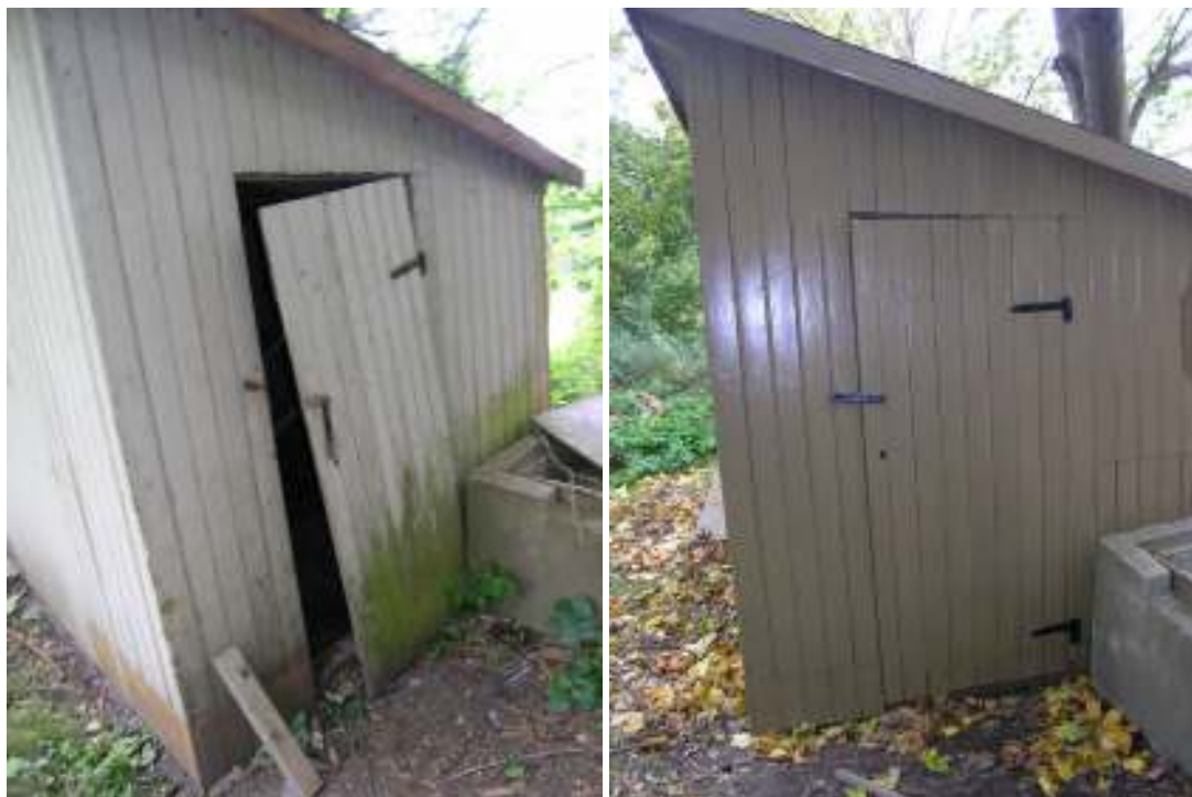
Uthusets norra gavel före och efter genomförd restaurering.
