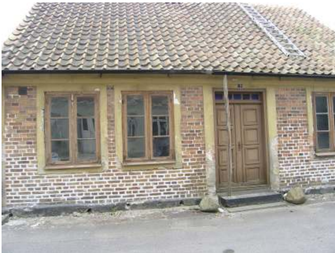
Hajen 13 i samband med att färgundersökningen gjordes och renoveringen just hade påbörjats.
