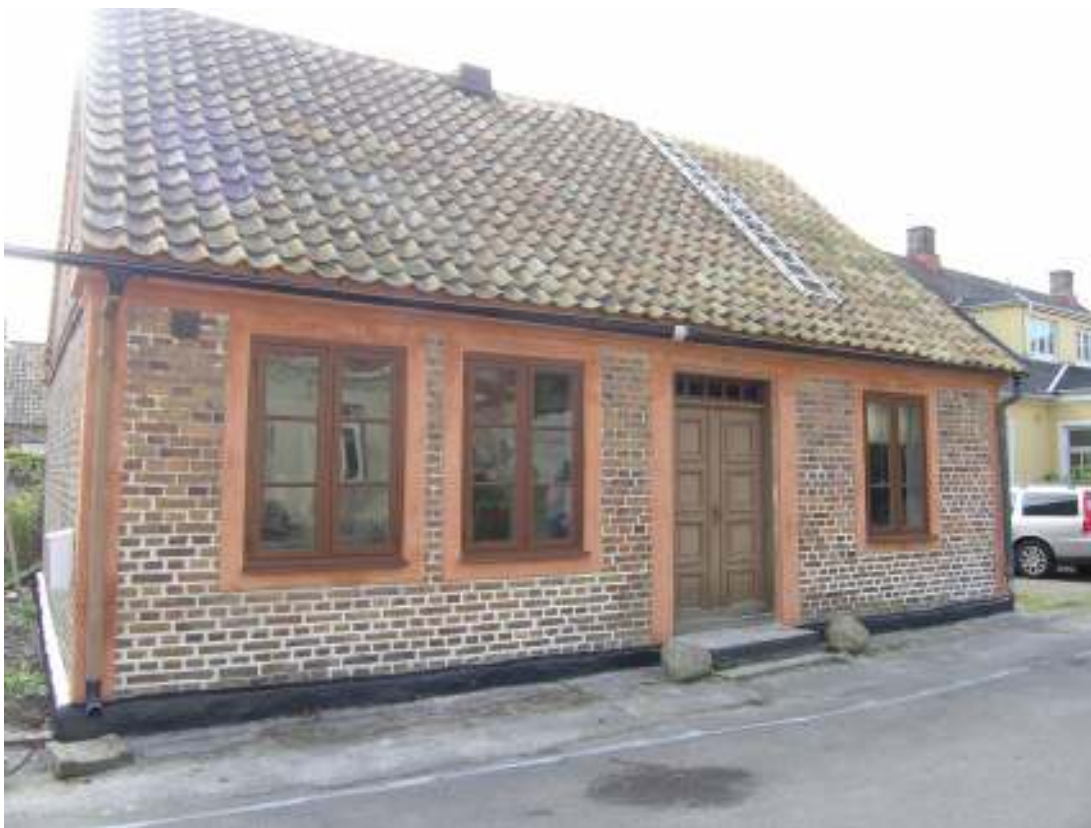
Hajen 13 i samband med slutbesiktningen. Fastighetsgränsen markerad med vitt i asfalten.
