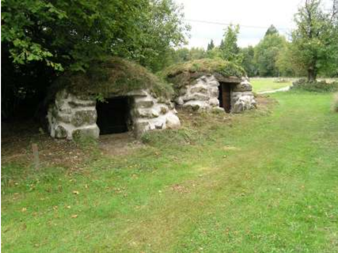
Täckarehusets jordkällare i samband med slutbesiktning.
