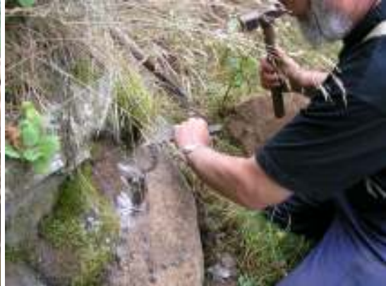
Bortknackning av cementhaltigt bruk.
