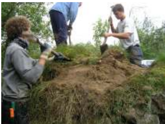
Frläggning av grästorv med hjälp av spadar.
