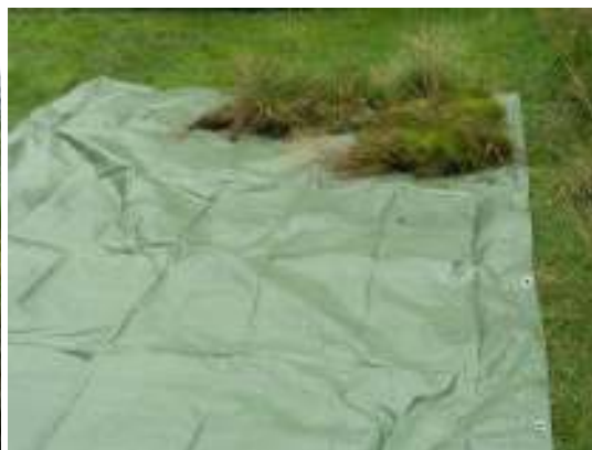
Grästorvsrutor placerade i enlighet med växtplats på jordkällarnas tak.
