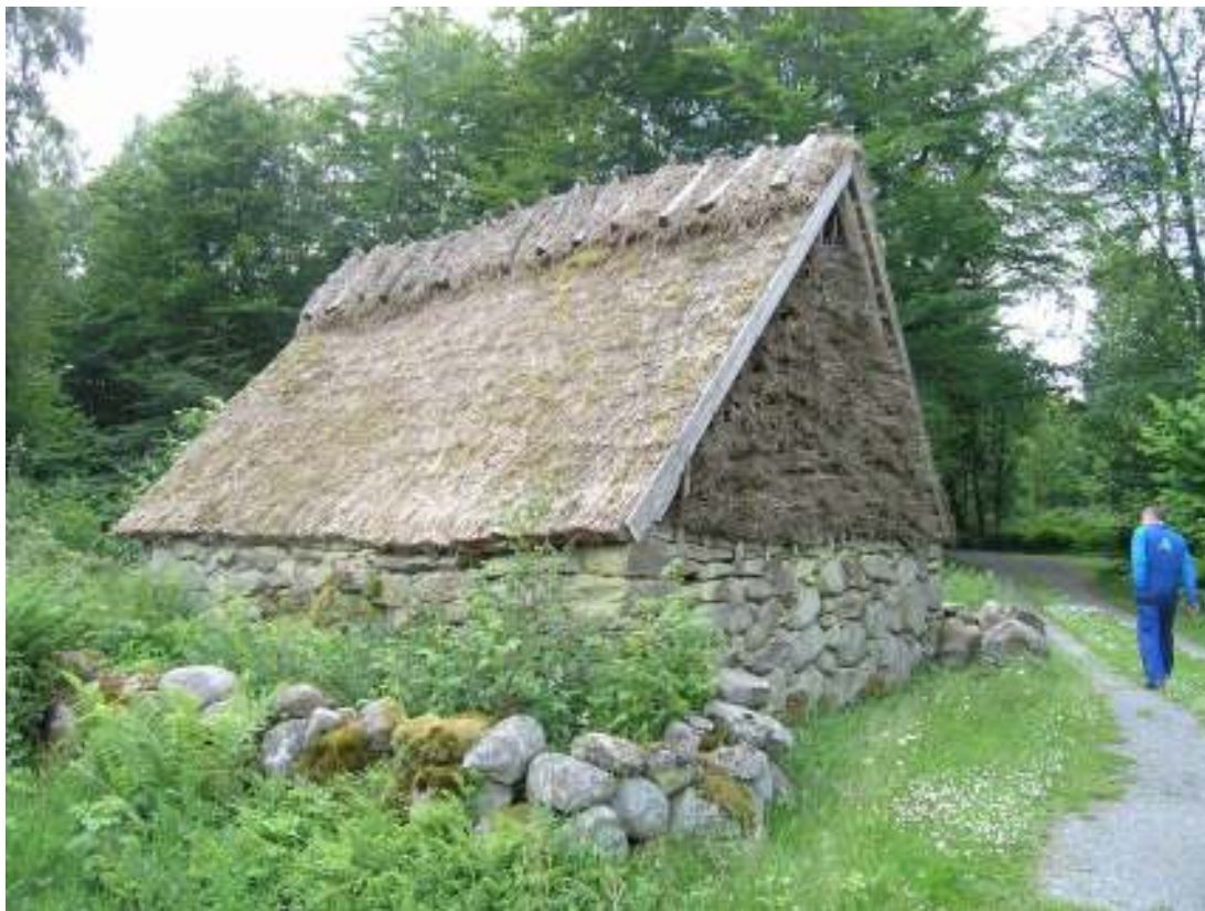
Koboden med dess särpräglade taktäckning samt täckning av gavelröste.
