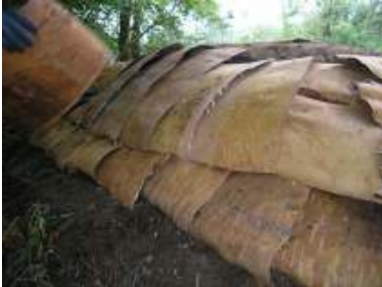
Läggning av tätande näverskikt
