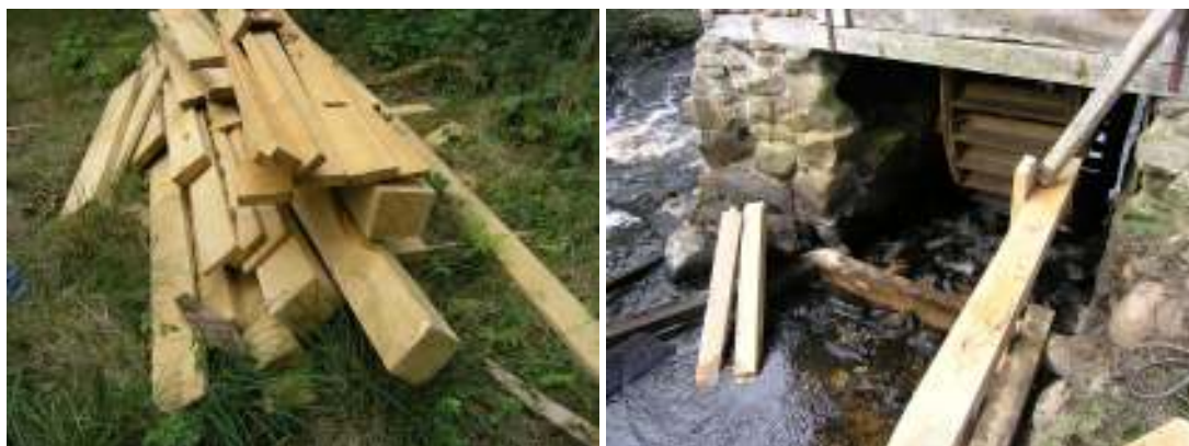
Upplag av lokalt avverkad ek i väntan på användning. Arbete med rekonstruktion av palissad och kvarnlucka.
