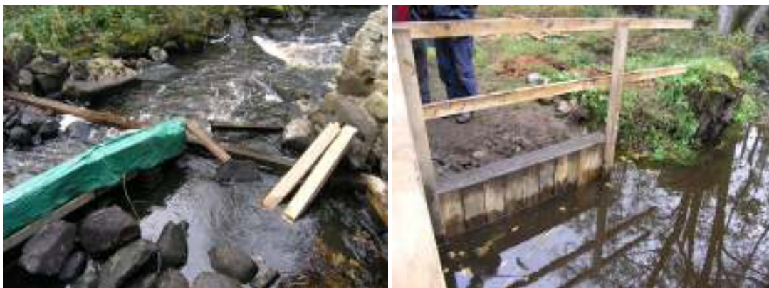
Arbetet med att rekonstruera dämnet har påbörjats.
