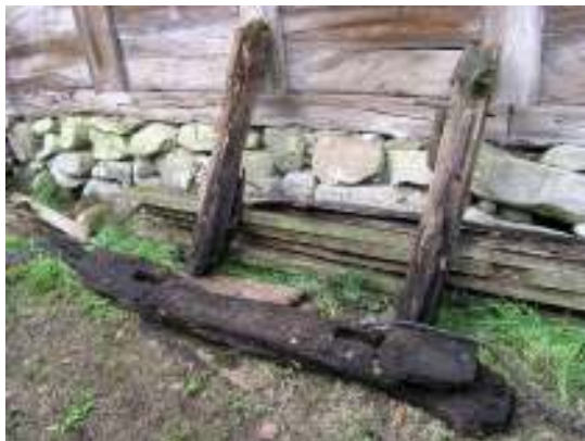
Delar av den äldre kvarnluckan i samband med uppmätning.
