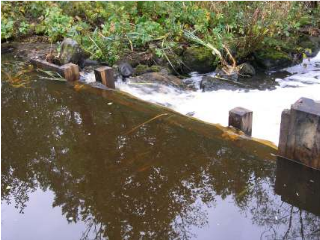
Ruveröds kvarns rekonstruerade dämme. I mitten av dämmet finns möjlighet att placera en bräda för att vid malning kunna dämna mer vatten och på så vis temporärt öka kvarnens kapacitet.
