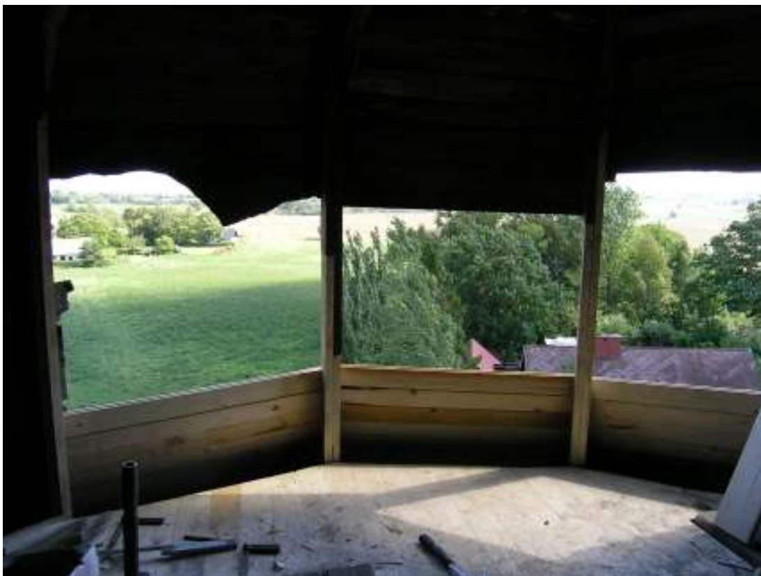
Vy från uppifrån hättan i samband med att ny underbrädning i form av råspont sattes upp.
