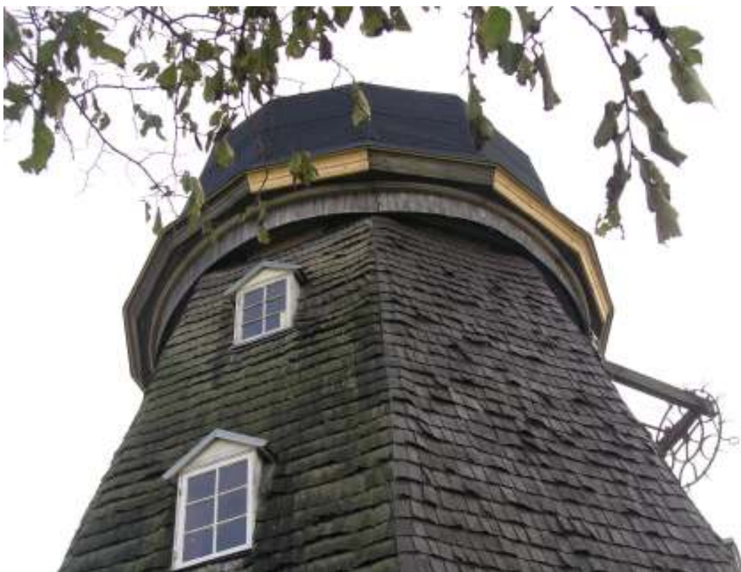
Detalj av hättans vridkrans, där flera delar har fått bytas ut eftersom skadorna på kransbräderna var så stora.
