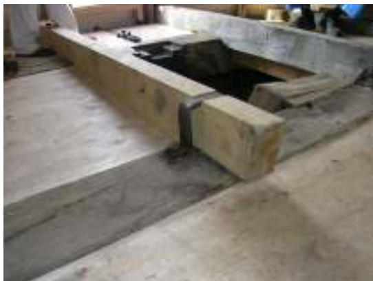
Detalj av interiör förankring av den nya utestickaren.
