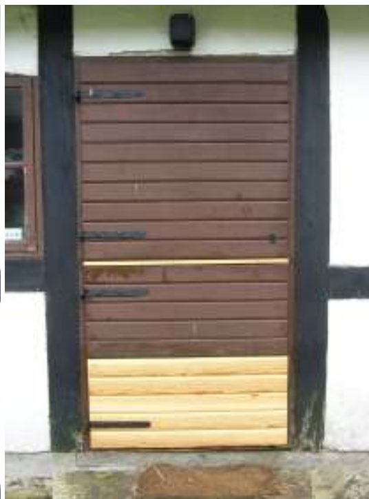
Dörr till boningsdelen, södra längan, med nya panelbräder (1).
