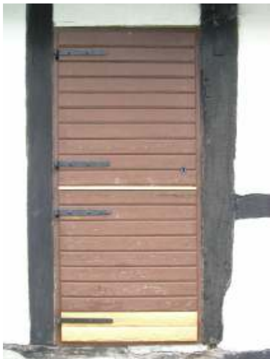
Dörr till östra längan efter åtgärder (3).
