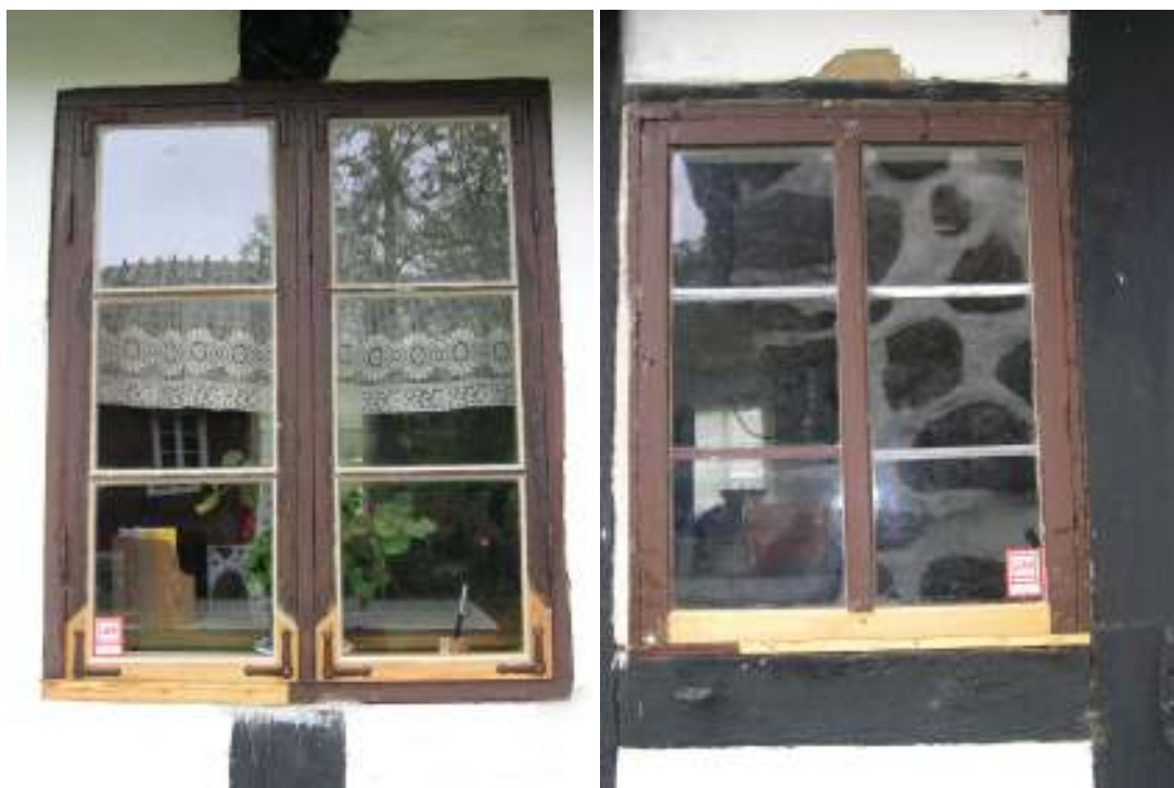
Fönster på östra längans västra fasad efter restaurering (5). Fönster på boningsdelens, södra längans, norra fasad (4).
