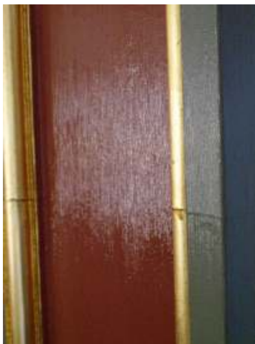
Bild 4: Orgelfasaden efter avslutat arbete. Bild 5: Färgen har troligen inte drivits ut i tillräcklig omfattning därav de strimmiga resultatet.
