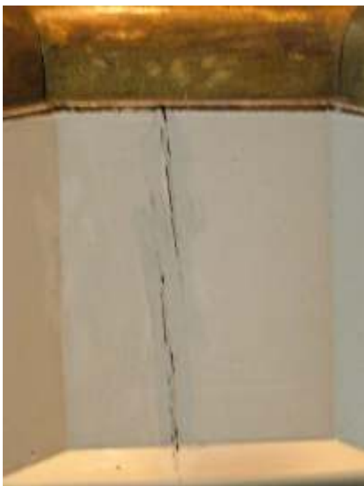
Bild 2: Sprickbildning i träet med påföljande färgflagning innan arbetenas början. Bild 3: Oxiderad slagmetallförgyllning i orgelns krönparti före arbetenas början.
