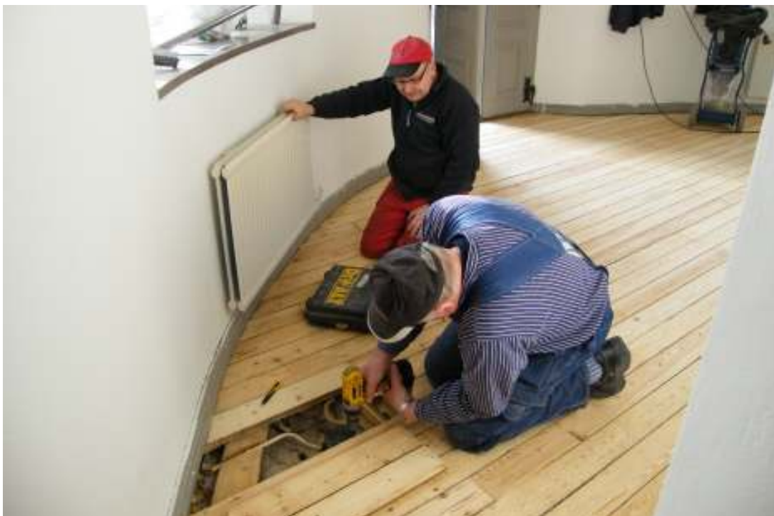
Absidgolvet efter slipningen samt platsen för de skadade golvbrädorna och elkabeln. Foto Sven-Åke Andén Nilsson, 2009.
