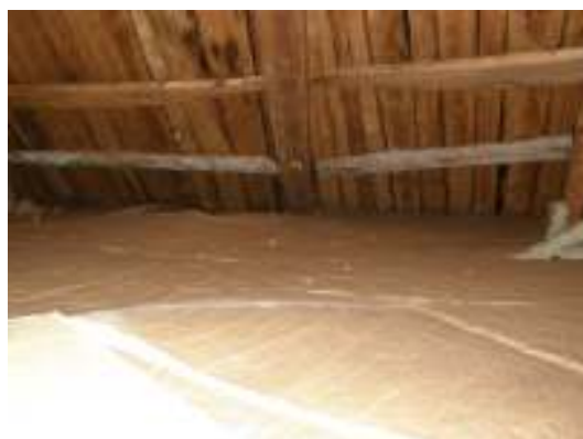
Isoleringen kompletterad.
