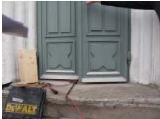
Yttre dörrbladen reparerade.
