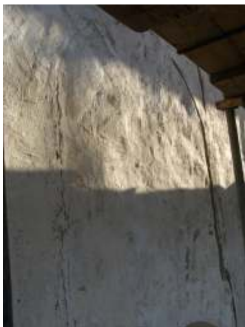
Bild 2: Tornets övre del med kraftig nedsmutsning på framförallt tinnarna. Bild 3: Sprickbildningar i de putsade fasaderna förekom endast på kyrkans södra sida och kunde lokaliseras till äldre igenmurade fönsteröppningar. På bilden är sprickbildningen delvis uppbuggen.
