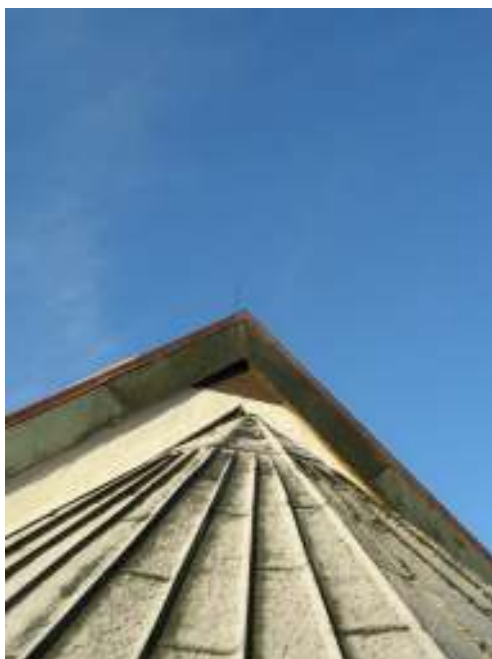
Bild 4: Korets kopparklädda vindskiva fick en extra kopparbeklädnad i överkant för att kompensera för takfallets kraftigare takläkt. Bild 5: Nykyrkans två takfall innan arbetenas genomförande. De inre takfallen lades om med helt nya pannor av fabrikat Vittinge P4. Ränndalens kopparbeklädnad byttes ut liksom den kopparklädda takluckan.
