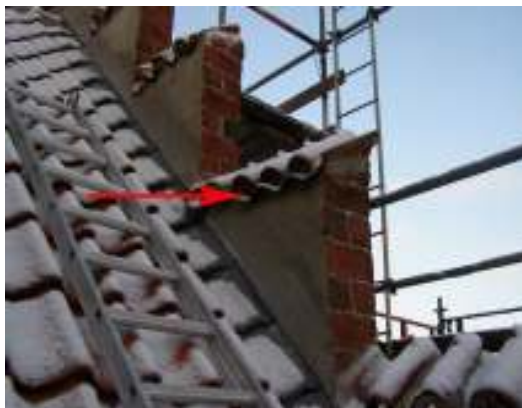
Bild 6: Blyplåt instucken under de nya munkpannorna på nykyrkans tinnar. Lösningen är tidsbegränsad till 2 år efter antikvarisk slutbesiktning, under vilken tid beställaren letar efter pannor med större längdmått. Bild 7: Rötskadat virke i nykyrkans rännadal.
