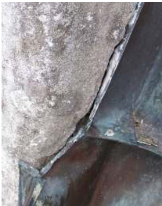
Bild 8: Plåtavtäckningarna av koppar hade dålig anslutning mot de putsade fasaderna med vatteninträning som följd. Bild 9: Befintliga kopparavtäckningar behölls men för att göra minsta möjliga åverkan i murverket bögs de inte in i detta utan kompletterades med en blyplåt som putsen anslöts mot.
