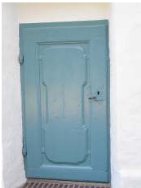
Bild 12: Dörr, troligen från 1600-talets mitt, på nykyrkans västra fasad. Under den nu påförda målningsbehandlingen finns flera äldre målningskikt, bland annat ett tjockt lager platsfärg, troligen latex från 1970-talet. Bild 13: Fastigheten Hovrätten 39 i Kristianstad har ett liknande dörrblad i behåll. Bevarade ytterportar från denna period är relativt ovanliga i Skåne.
