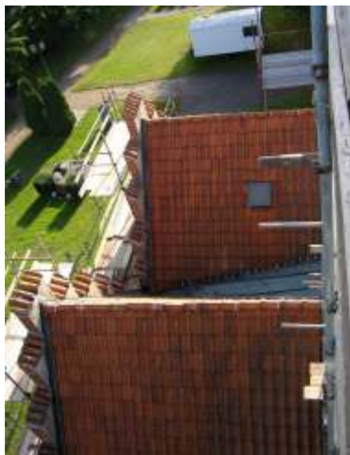
Bild 4: Korets kopparklädda vindskiva fick en extra kopparbeklädnad i överkant för att kompensera för takfallets kraftigare takläkt. Bild 5: Nykyrkans två takfall innan arbetenas genomförande. De inre takfallen lades om med helt nya pannor av fabrikat Vittinge P4. Ränndalens kopparbeklädnad byttes ut liksom den kopparklädda takluckan.
