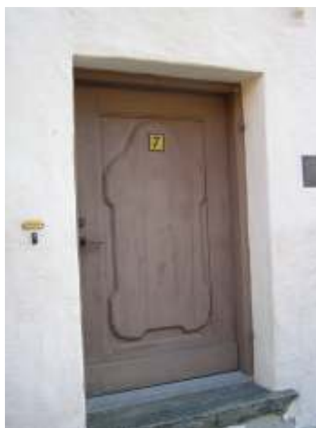
Bild 12: Dörr, troligen från 1600-talets mitt, på nykyrkans västra fasad. Under den nu påförda målningsbehandlingen finns flera äldre målningskikt, bland annat ett tjockt lager platsfärg, troligen latex från 1970-talet. Bild 13: Fastigheten Hovrätten 39 i Kristianstad har ett liknande dörrblad i behåll. Bevarade ytterportar från denna period är relativt ovanliga i Skåne.
