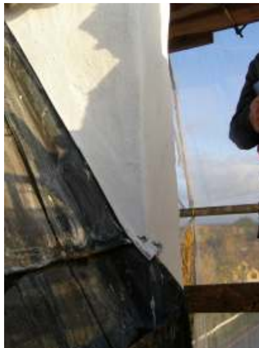
Bild 8: Plåtavtäckningarna av koppar hade dålig anslutning mot de putsade fasaderna med vatteninträning som följd. Bild 9: Befintliga kopparavtäckningar behölls men för att göra minsta möjliga åverkan i murverket bögs de inte in i detta utan kompletterades med en blyplåt som putsen anslöts mot.
