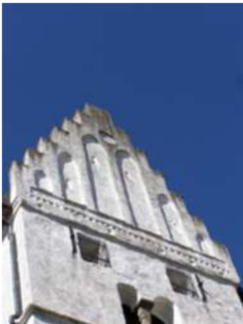
Bild 2: Tornets övre del med kraftig nedsmutsning på framförallt tinnarna. Bild 3: Sprickbildningar i de putsade fasaderna förekom endast på kyrkans södra sida och kunde lokaliseras till äldre igenmurade fönsteröppningar. På bilden är sprickbildningen delvis uppbuggen.
