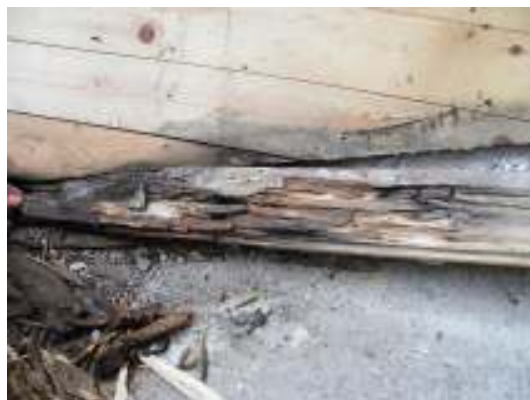
Bild 6: Blyplåt instucken under de nya munkpannorna på nykyrkans tinnar. Lösningen är tidsbegränsad till 2 år efter antikvarisk slutbesiktning, under vilken tid beställaren letar efter pannor med större längdmått. Bild 7: Rötskadat virke i nykyrkans rännadal.
