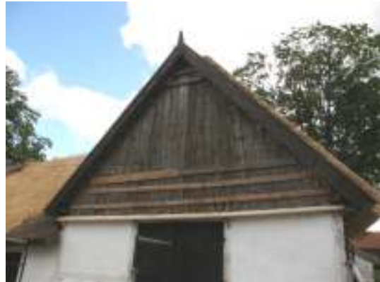
Efter att gammalt stråmaterial avlägsnats.
