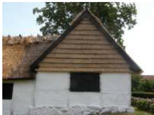
Västra gavelspetsen efter arbetet.
