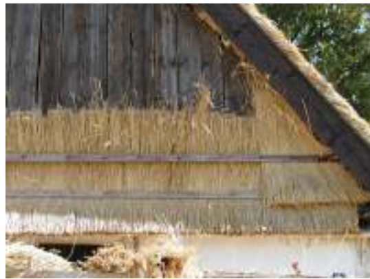
Under arbetet att fästa ny halm.
