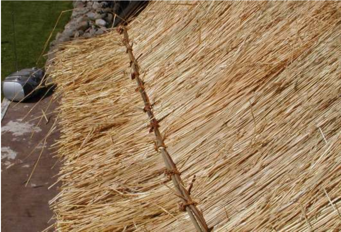
Detalj på vidjebindningen vid södra längans takfot, dvs första halmskiftet.
