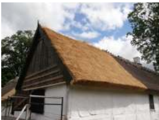
Södra längan efter omtäckning.
