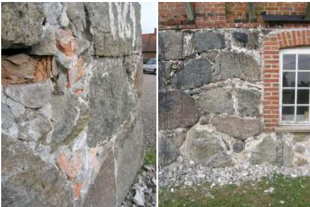
Även tegelstenar har använts som kilstenar.
