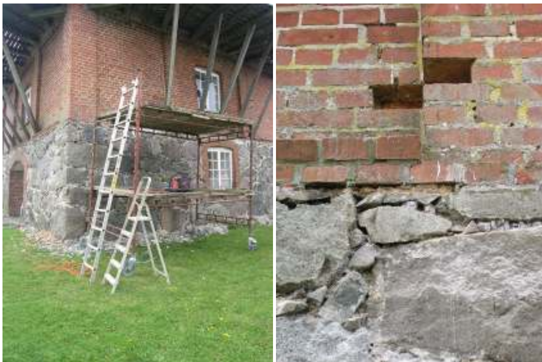
Entreprenörens mobila byggnadsställning.
