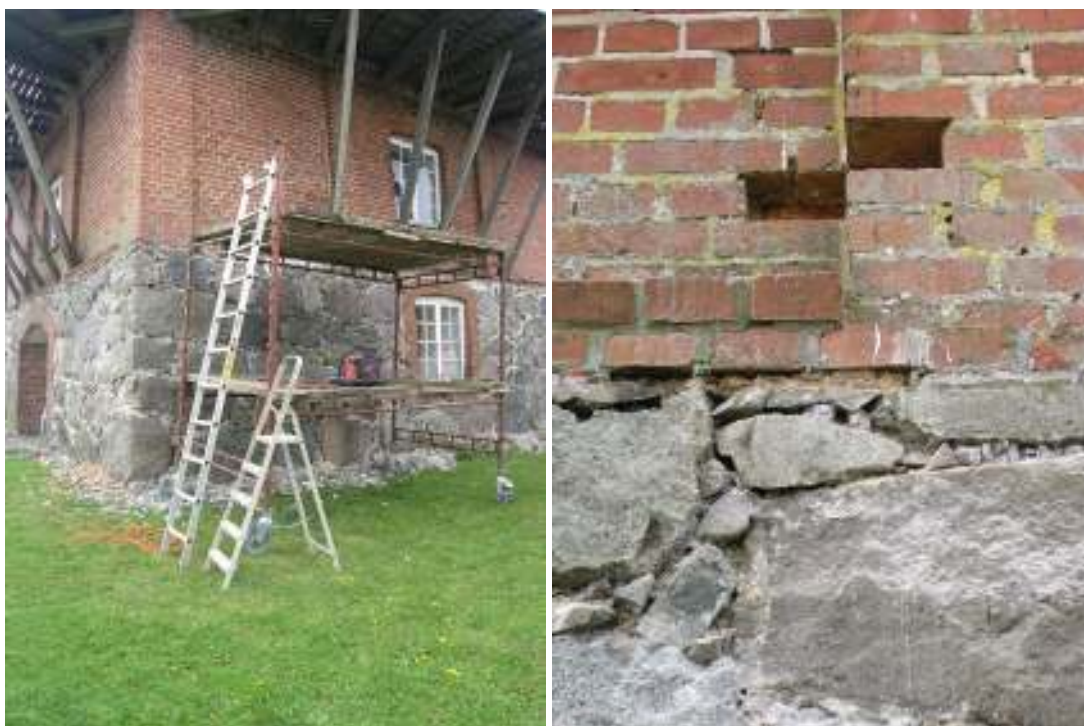
Entreprenörens mobila byggnadsställning.
