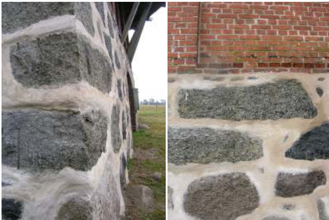
Portloftets stenmur har fått nyputsade fogar.
