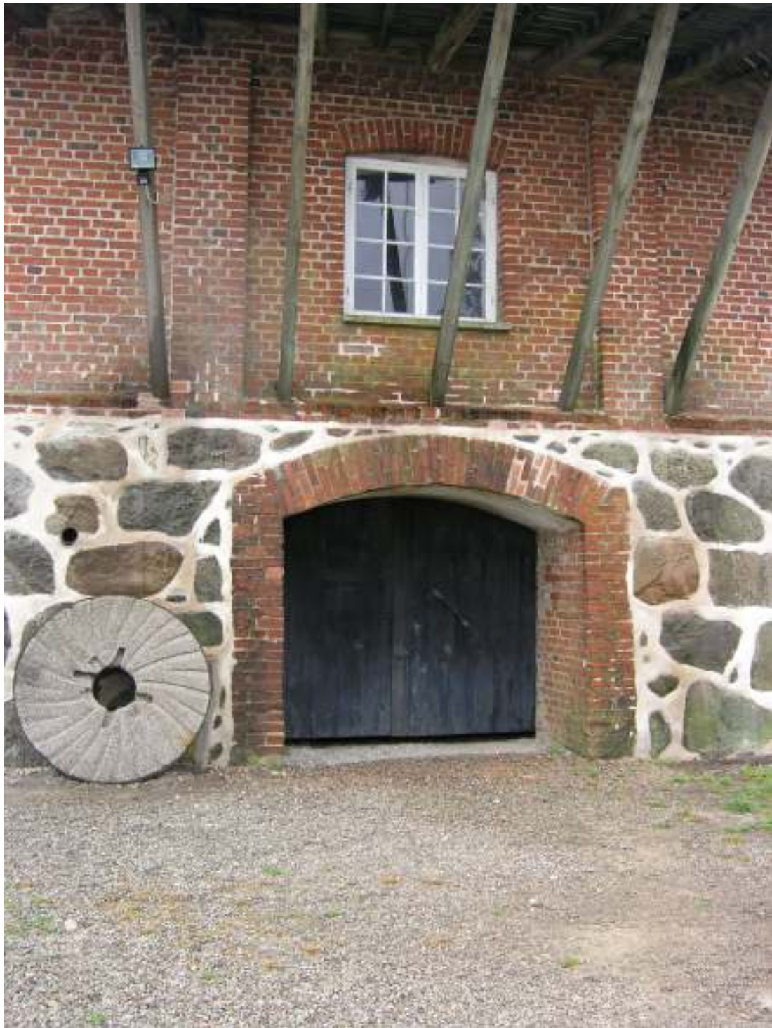
Porten liksom omgivande naturstensmur och ovanvarande murverk i tegel ståtar med nya fogar liksom kompletterade tegelstenar.
