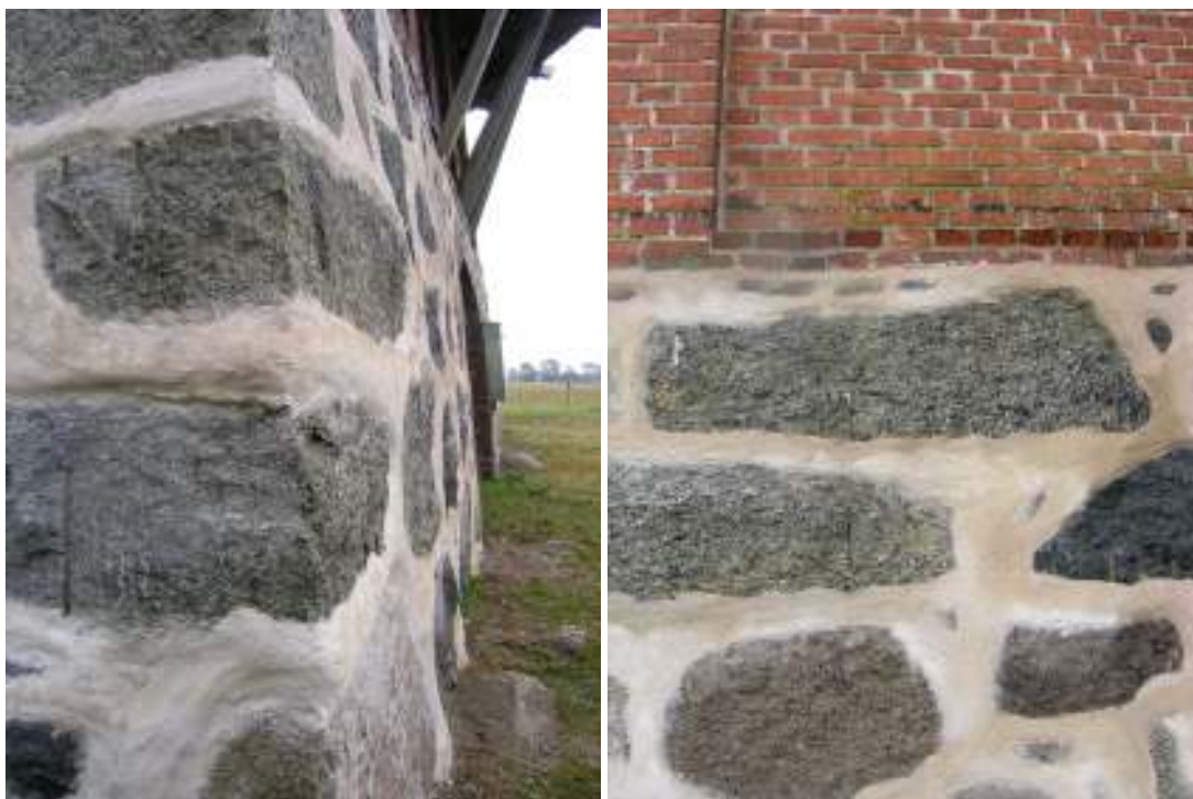
Portloftets stenmur har fått nyputsade fogar.
