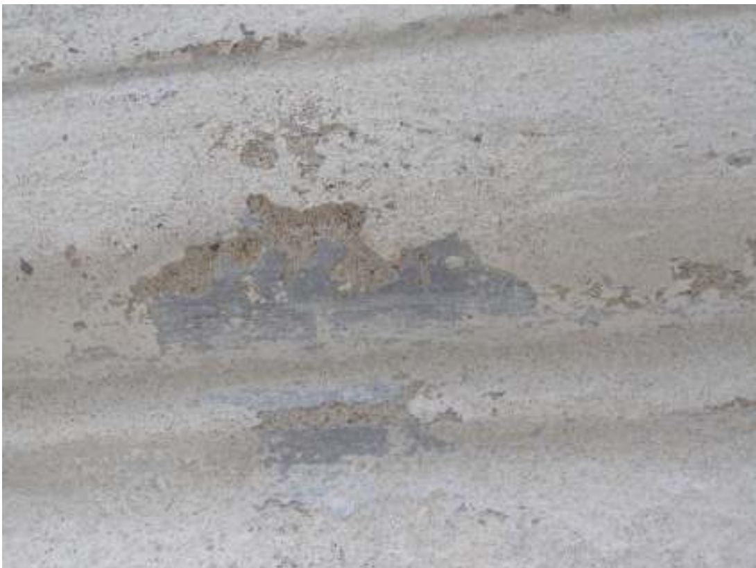
Bild 5 överst t.v.: Sjupassformat överstycke till södra korsarmens portal efter avslutad rengöring. Överstycket är troligen prefabricerat i gjuten cement. Bild 6 överst t.h.: Korintiskt kapitäl i gjuten cement vid tornets ljudöppningar. Tre av fyra kapitäl är i mycket dåligt skick och vid nästkommande renovering kan ett eventuellt byte bli nödvändigt. Bild 7 nederst: Spår efter grå kulör på taklist på korets södra sida styrker teorin om att kyrkans troligen prefabricerade gjutna cementdetaljer från början varit utan anfärgning och framstätt grå mot omgivande vita ytor.
