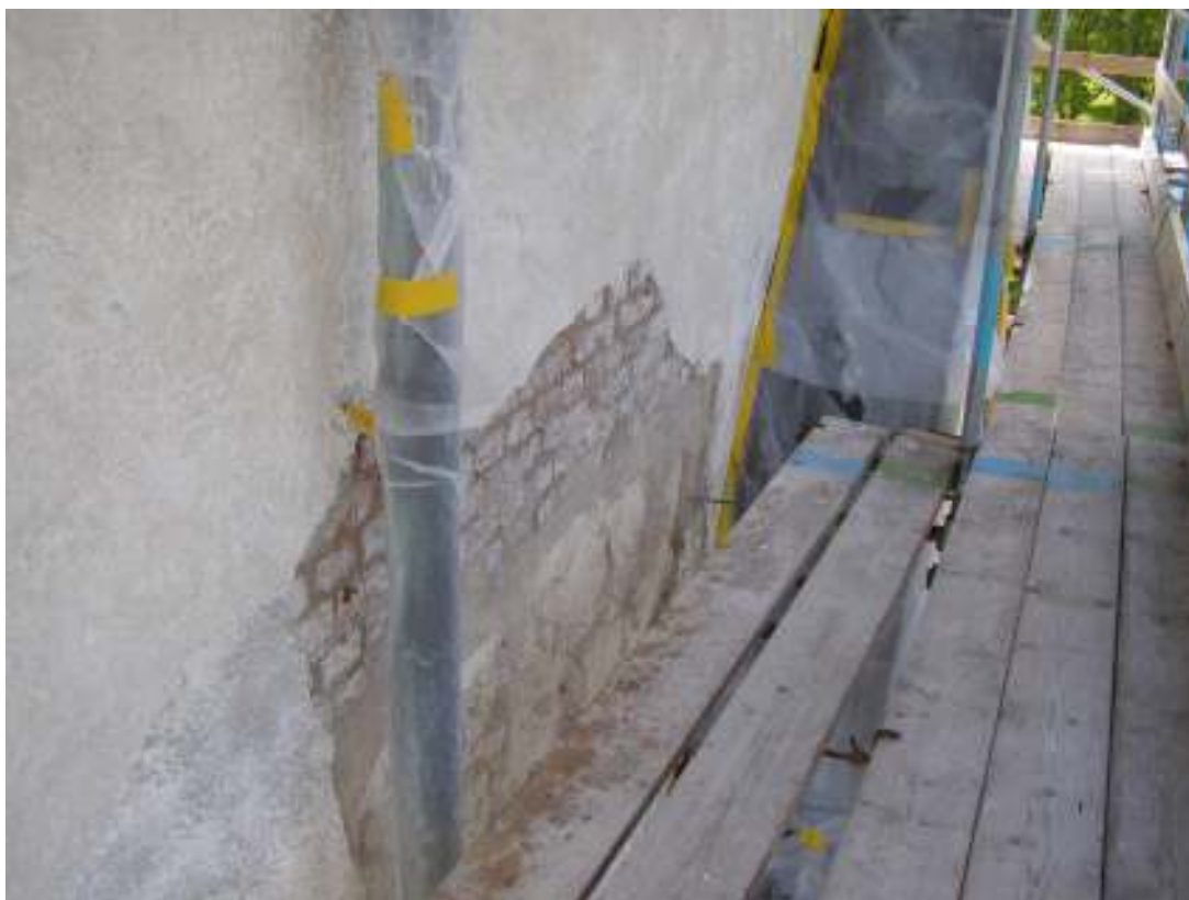
Bild 9 ovan: Skarv mellan naturstensmurverk och tegelmurverk på tornets västra fasad.
