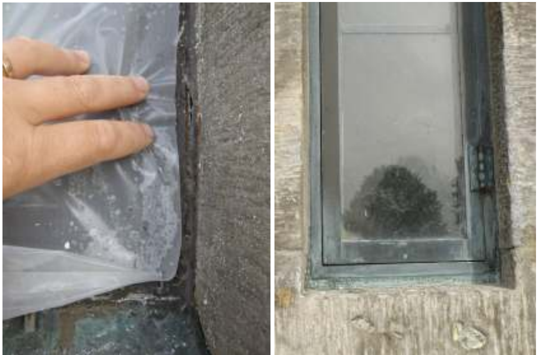
Sakerstians fönster mot väst. Gammal silikon och latexmassa kring fönster och använd som fogmassa avlägsnades.
