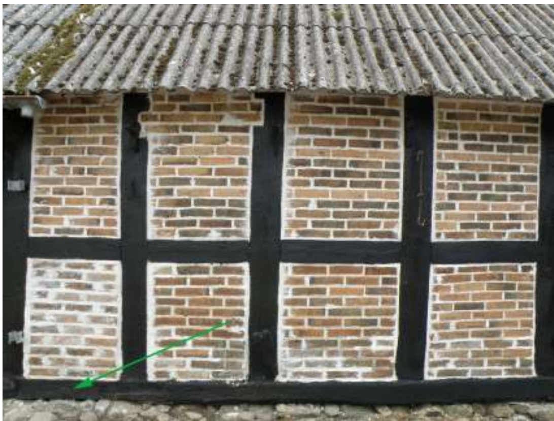
Östra längans gårdssida, söder om Vångaporten, efter syllbyte och omfogning av tegelfack. Pilen markerar den nya syllens skarvad halvt i halvt. Se även närbild på motstående sida.
