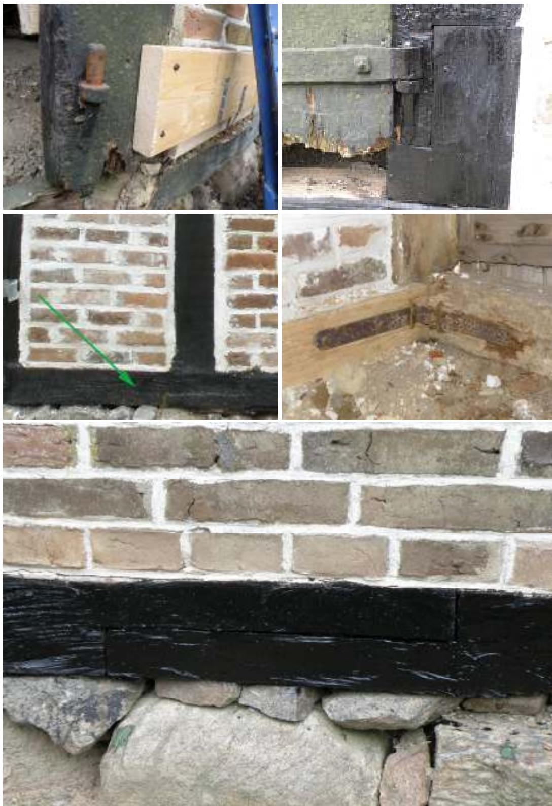
Överst: Den rötskadade hörnstolpen före och efter åtgärd. Mitten tv: den nya, mindre syllen i anslutning till Vångaporten på plats. Se även bild på sid 11. Th: Förstärkning av logens nordvästra hörn inifrån. Stora bilden: De två raka tjärstrukna bladen, söder om logdörrarna på plats. Grunden återmonterad. Teglet ovan är omfogat med slät fog. Fogpinne användes.
