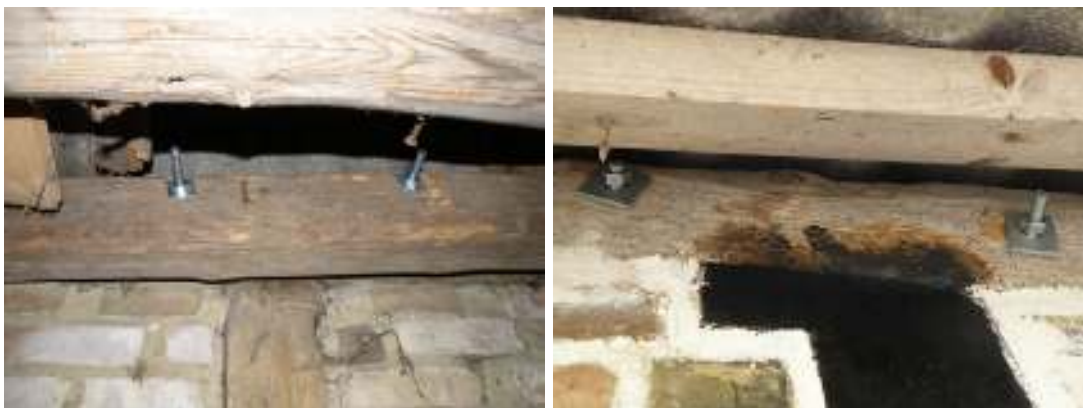
Den östra logens gårdssida försågs med dubbla lejder, enligt redan befintlig princip, på en sträcka av 2,50 m. Tv: inifrån logen, th: utifrån. De förnicklade bultarna kommer med tiden att rosta och därigenom bli mindre framträdande.
