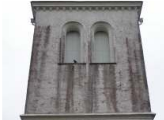
Bild 2 t.v.: Lackalänga kyrka sedd från väster med kraftigt nedsmutsade och algbeväckta fasader. Bild 3 ovan: Detalj av tornets övre del vilken var värst angripen av alger. Såväl röda som svarta alger förekom på fasaderna.
