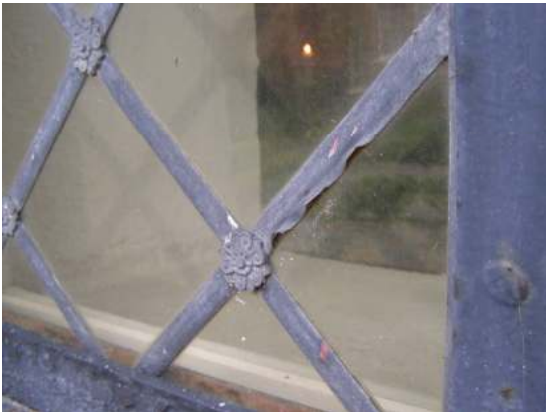
Bild 12: Långhuset och korets smidesjärnsfönster har rombiska glasrutor mes blyspröjs. I spröjsarnas skärningspunkter sitter dekorativt utformade blommor. På delar av blyspröjsen finns utmattningsskador orsakade av bland annat klimatvariationer, främst på södra sidan. Uttjänt blyspröjs har bytts ut och de dekorativa blommorna bevarats.
