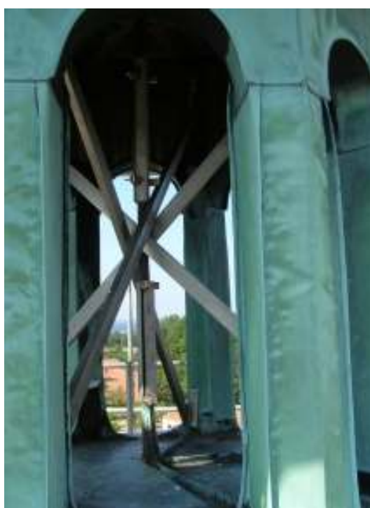
Bild 15 överst t.v: Västentréns stenramp har dragits runt hörnet på tornet i norr för att få rätt lutning. Bild 16 överst t.h: De gamla stagen i tornets öppna lanternin var kraftigt korroderade med några stag så gott som av. I lanterninen fanns delvis nytt virke vilket tyder på att man under de senaste decennierna utfört reparationer i träkonstruktionen. Bild 17 nederst t.v: Stagen i lanterninen ersattes delvis med nya av rostfritt stål vilket godkändes av antikvarisk ontrollant p g det utsatta läget. De nya stagen har målats i svart kulör.
