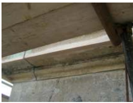
Bild 11 överst t.v: Stenkapitäl borttaget på tornet. Observera den ringa tjockleken på stenen. Bild 12 överst t.h: Klovspricka i stenornament på långhuset. Stenen är ställd på högkant vilket gör att klovsprickorna blir ett större problem än om den legat ner. Bild 13 nederst t.v: Tornets taklist med vittrad droppnäs innan lagning Bild 14 nederst t.v: Tornets taklist efter lagning med lagningsbruk.
