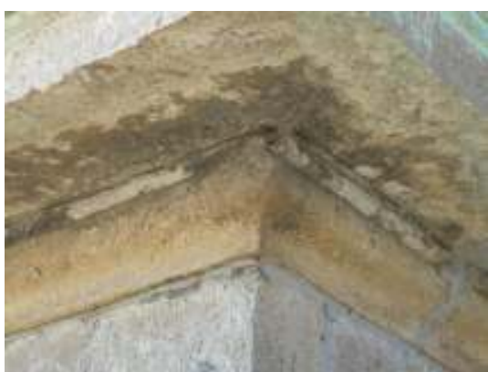
Bild 11 överst t.v: Stenkapitäl borttaget på tornet. Observera den ringa tjockleken på stenen. Bild 12 överst t.h: Klovspricka i stenornament på långhuset. Stenen är ställd på högkant vilket gör att klovsprickorna blir ett större problem än om den legat ner. Bild 13 nederst t.v: Tornets taklist med vittrad droppnäs innan lagning Bild 14 nederst t.v: Tornets taklist efter lagning med lagningsbruk.
