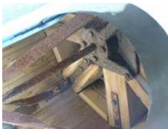
Bild 15 överst t.v: Västentréns stenramp har dragits runt hörnet på tornet i norr för att få rätt lutning. Bild 16 överst t.h: De gamla stagen i tornets öppna lanternin var kraftigt korroderade med några stag så gott som av. I lanterninen fanns delvis nytt virke vilket tyder på att man under de senaste decennierna utfört reparationer i träkonstruktionen. Bild 17 nederst t.v: Stagen i lanterninen ersattes delvis med nya av rostfritt stål vilket godkändes av antikvarisk ontrollant p g det utsatta läget. De nya stagen har målats i svart kulör.
