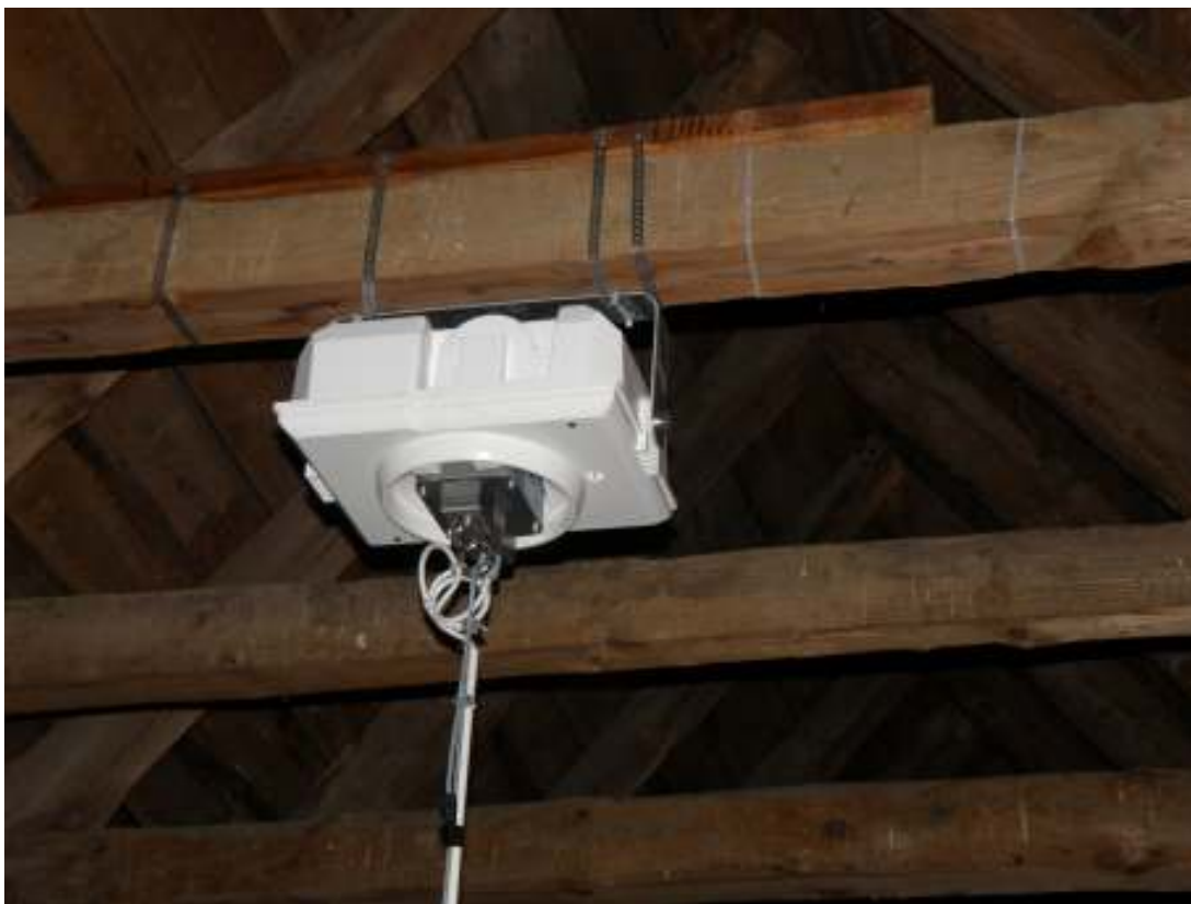
Motorpaketet till den lilla ljuskronan i väster hänger i spännband av metall runt en löst ditlagd träbjälke. Alla infästningar gjordes i den nya bjälken för att undvika håltagning i bindbjälkarna.
