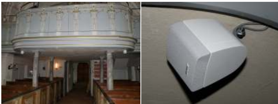
Nya högtalare av typen enkelkuber placerades under läktaren.
