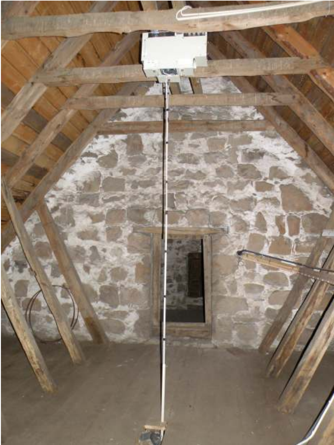
Behyvningslift till stora ljuskronan mot öst. Inga nya håltagningar i tak- eller golvhjälklag behövde göras.
