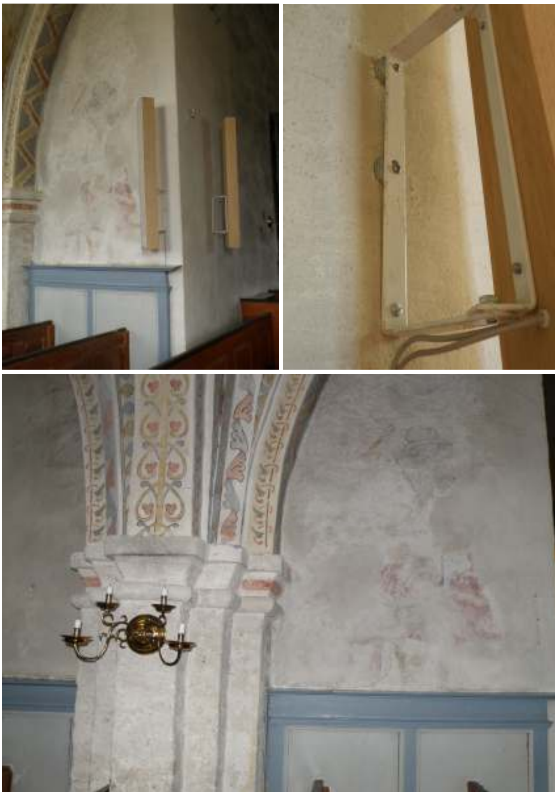
Övre raden. Tv: Kyrkorummet före åtgärd. Långhusets norra vägg samt Nykyrkans västra vägg. Th: Närbild av fästning. Stora bilden underst: Långhusets norra vägg efter demontering av de tidigare pelarhögtalarna.
