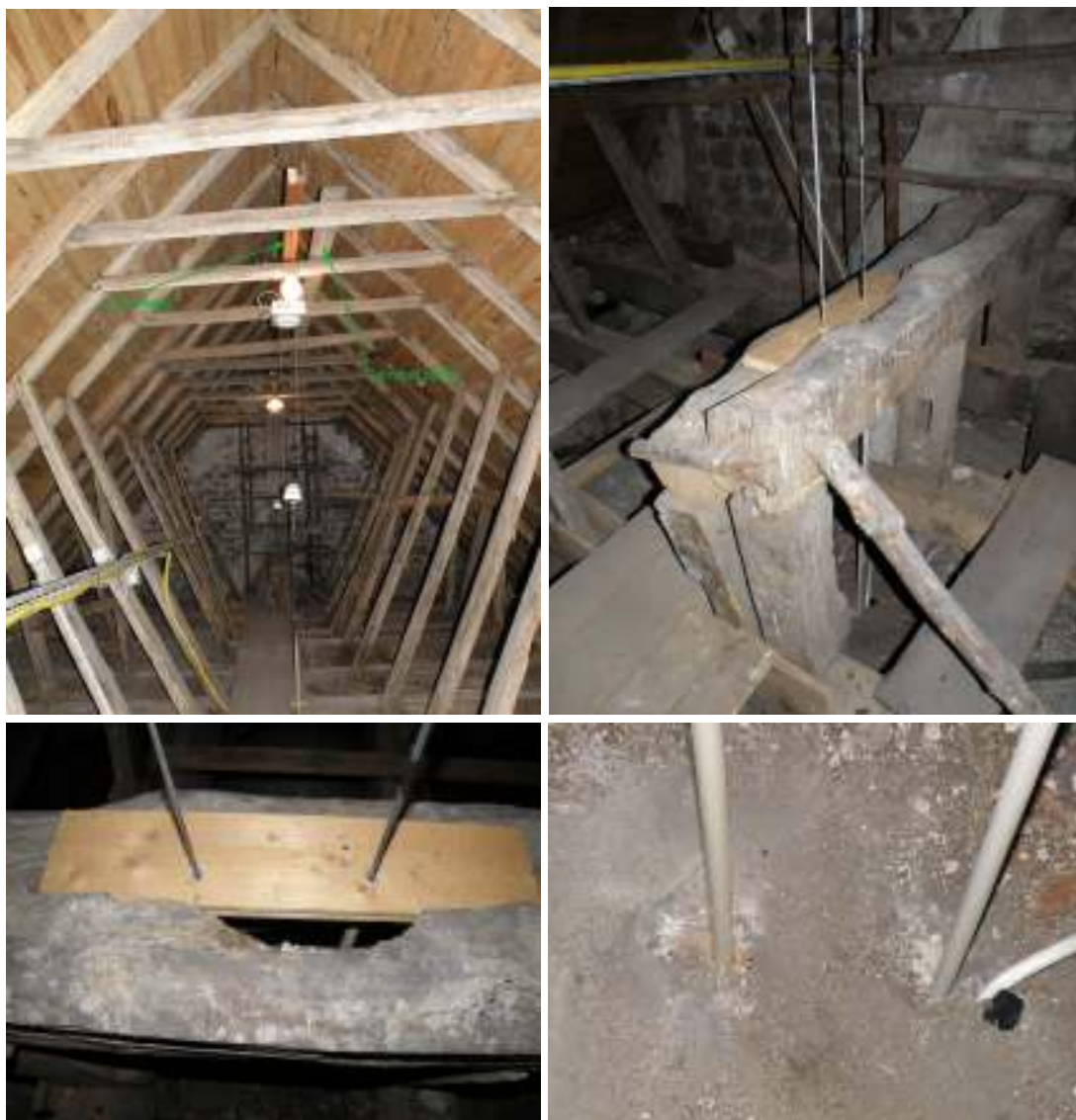
Övre raden, fr v: Långhusvinden, från väst, efter installation av två belysningsliftar till ljuskronor. På bilden syns liftarna i nedsänkt läge. T v: Vajrar tillhörande lift till den östra ljuskronan. Undre raden, fr v: närbild från föregående motiv. Lösning för montering av hissmotorpaket med belysningslift tillhörande den östra ljuskronan. Brädan är ett tillägg med anledning av aktuell installation. T h: Kablar till östra ljuskronan, långhusvinden.
