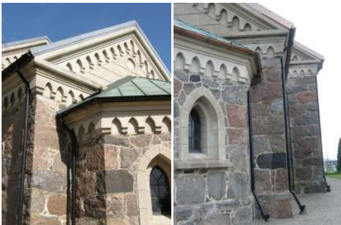
Sakristia och kor före och efter åtgärder. Tv: kyrkan från sydost med hängskivor i galvaniserad järnplåt. Th: Kyrkan från nordost efter 2008 års åtgärder. Notera hängskivor och rännor i kopparplåt.
