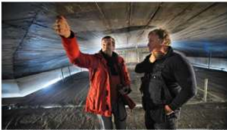
Byggnadsantikvarie Heikki Ranta tar en titt på taket tillsammans med byggjobbaren Göran Johansson. Bilden: www.nippon.se
