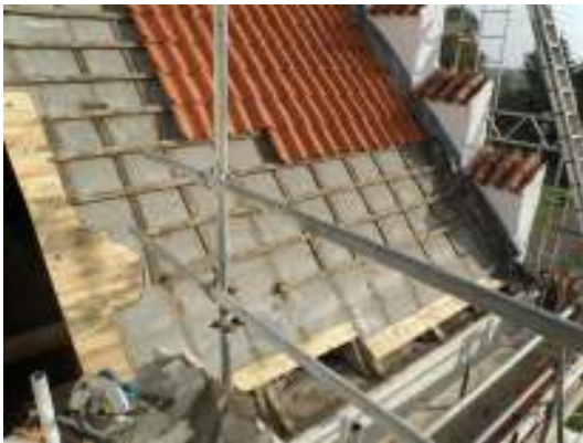
Kortaket under pågående renovering. En mindre lagning gjordes mot sydväst och lagningar utfördes även vid takfot. Vid sydöstra lagades takfotens intäckning.
