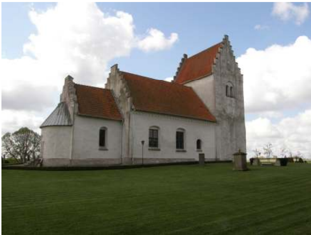
Kyrkan från nordost före renovering. Sockeln var före renoveringen avfärgad i vitt men missfärgning från alger gör att den ser nästan röd ut.
