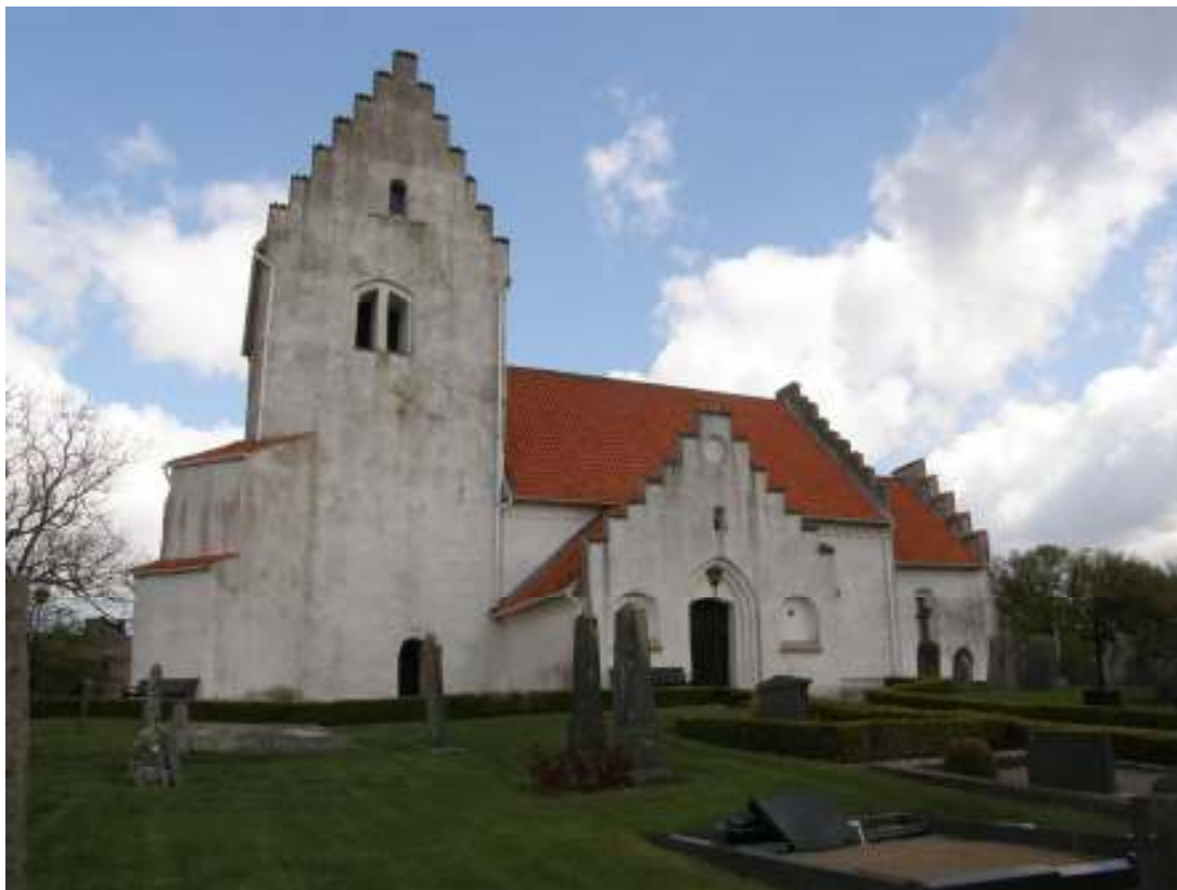
Kyrkan från söder före renoveringen.
