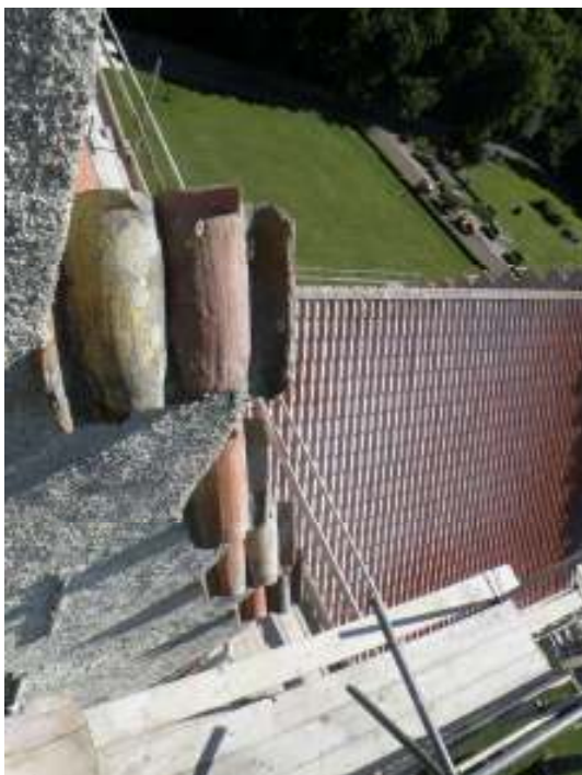
Torntinnarna är avtäckta med enkupigt tegel av olika utseende. Till höger syns det norra fönstret till tornvinden.
