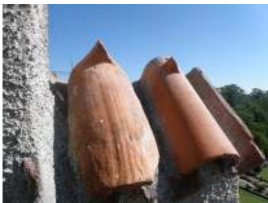
Till vänster syns avtäckning av torntinnar och till höger avtäckning på vapenbusets trappsteg.
