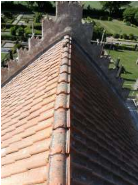
Långbusets tegeltak före renovering. Nockpannor bestod av vingtegelpannor liksom på vapenuset. Till höger syns vapenbusets tak och dess södra gavel.
