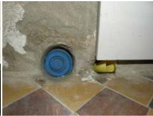
Rör för ledningar drogs genom pågjutning, genom tornmur in till tornets bottenvåning. Till vänster syns ingången för tomrör i tornets bottenvåning södra väggen, under tornttrappan.
