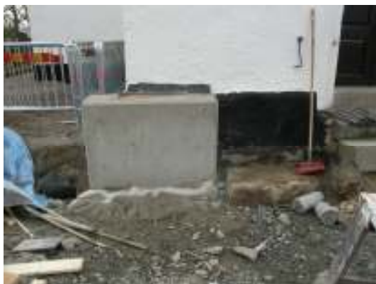
Betongfundament för räcket vid tornets nordvästra hörn. En sten sprängdes delvis bort framför denna. Till vänster syns vilplanet framför ingången till tornet.
