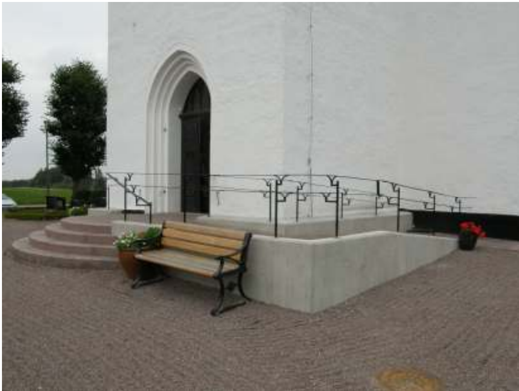
Ny ramp och trappa sett från sydväst.
