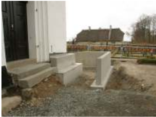
Rampens stödmurar står på plats.
