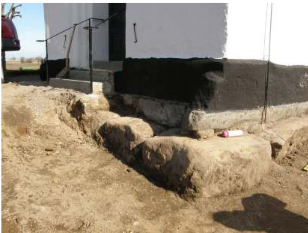
Tornets grundläggning består av kraftiga utskjutande stenblock.
