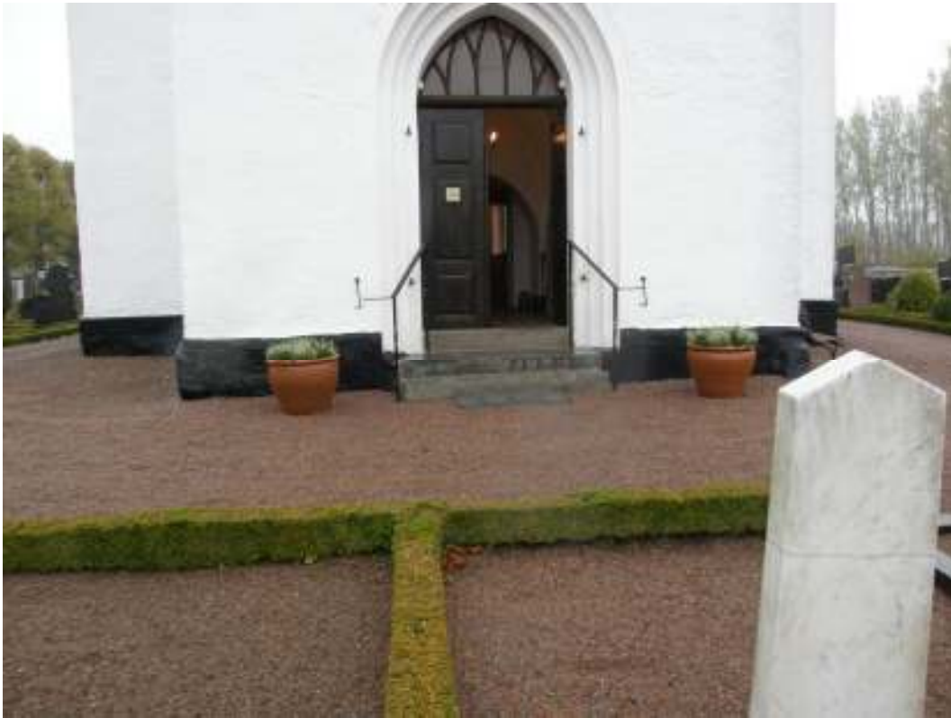
Tornet sett från väster, före rampens tillkomst.
