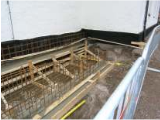
Gjutning av rampens stödmurar.
